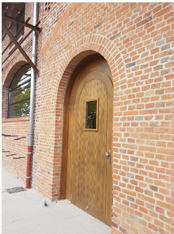
Figure 10 : Nouvelle porte en bois pour l'accès à la cyberbase
