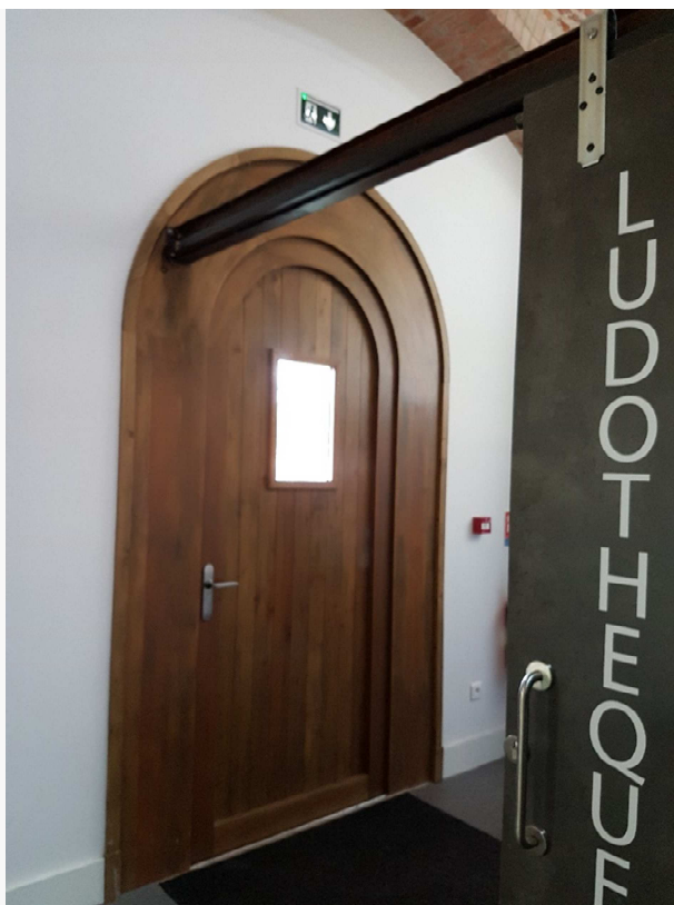
Figure 18 : Système coulissant de fermeture des espaces
