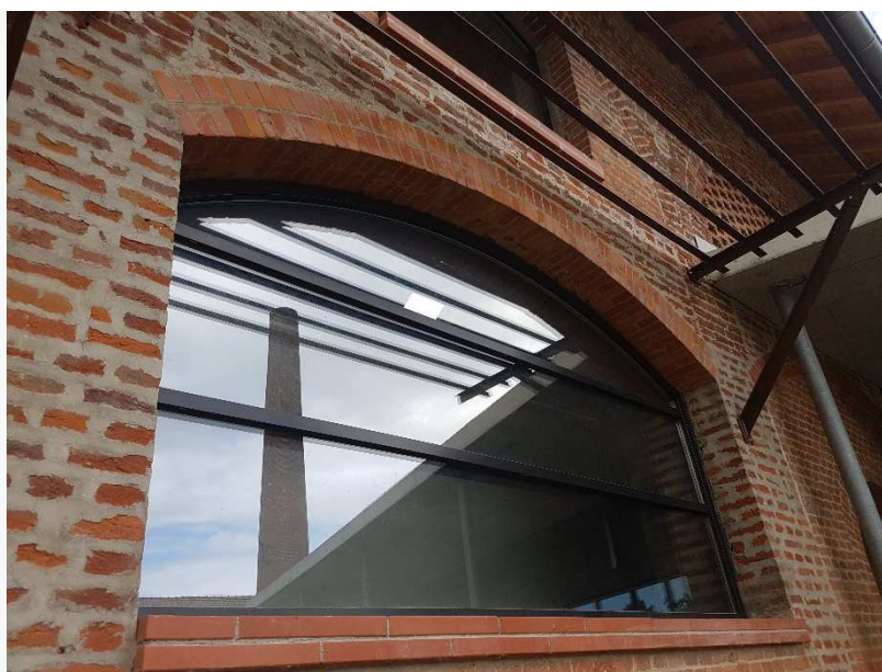
Figure 9 : Nouvelle menuiserie aluminium
