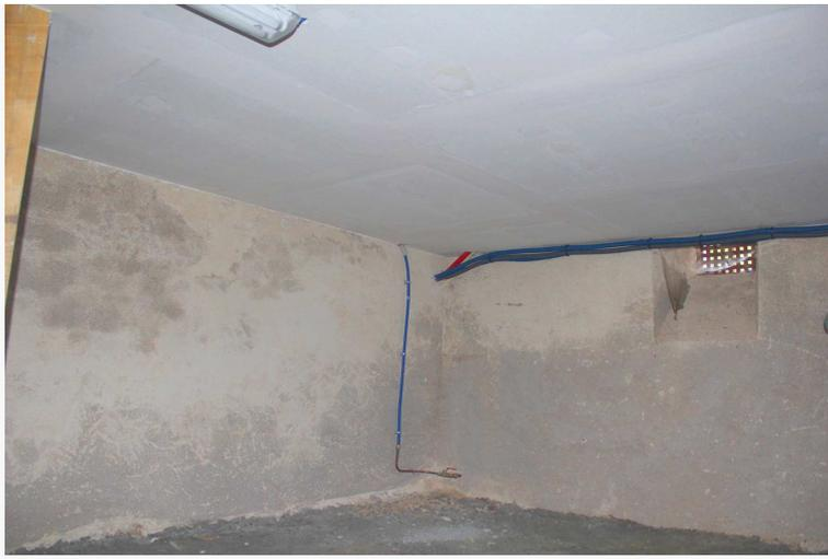
Figure 31 : Logement 2 – Cave isolée en laine de chanvre et doublage en plaques de plâtre (source : CREBA)
