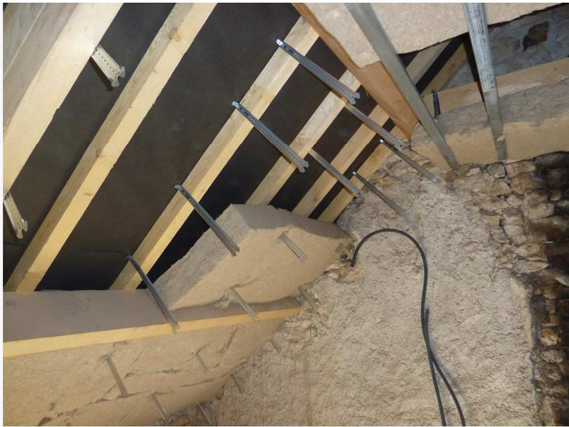
Figure 29 : Isolation des rampants – 200 mm laine de chanvre
