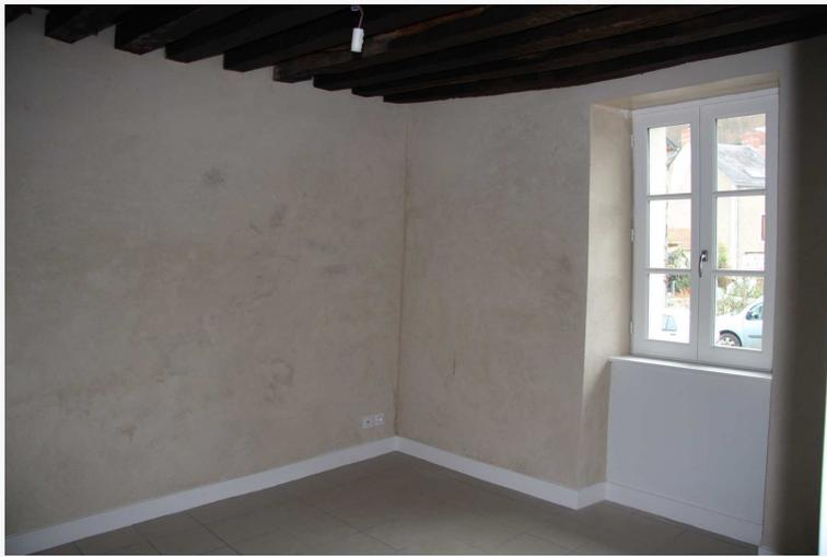
Figure 28 : Finition par des enduits à la chaux naturelle posée sur l'enduit chaux-chanvre (source : CREBA)
