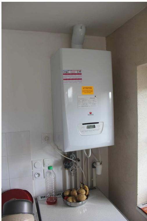
Figure 33 : Chaudière gaz à condensation individuelle (source : CREBA)
