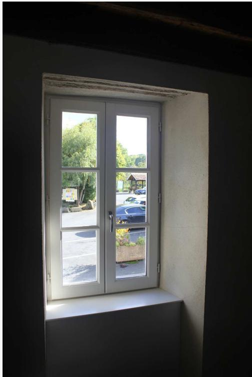
Figure 32 : Logement 3 – Fenêtre battante bois (source : CREBA)
