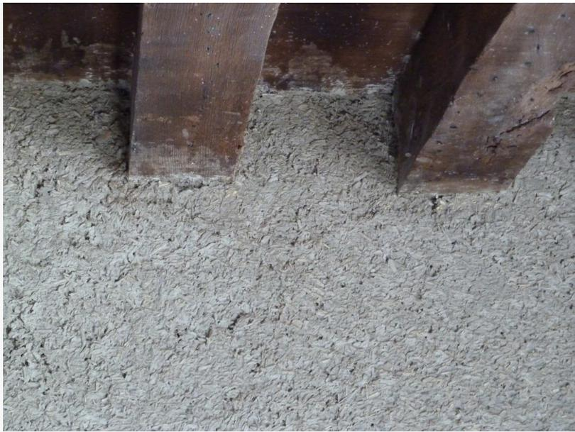
Figure 27 : Enduit chaux-chanvre projeté sur les murs
