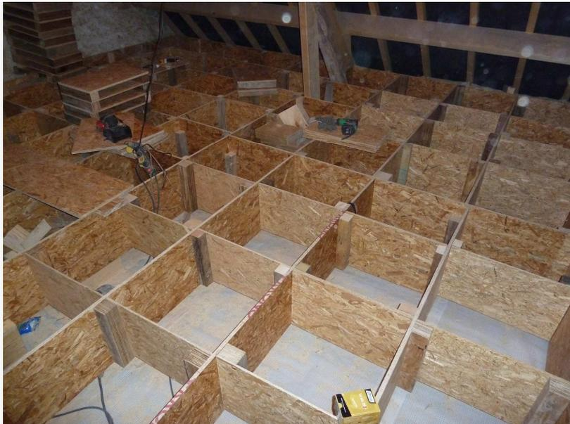
Figure 30 : Isolation du plancher des combles par ouate de cellulose en caisson
