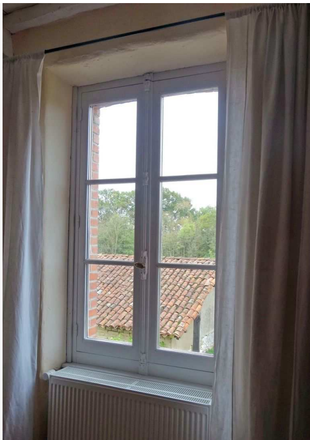
Figure 16 : Une fenêtre préservée et complétée avec un double-vitrage
