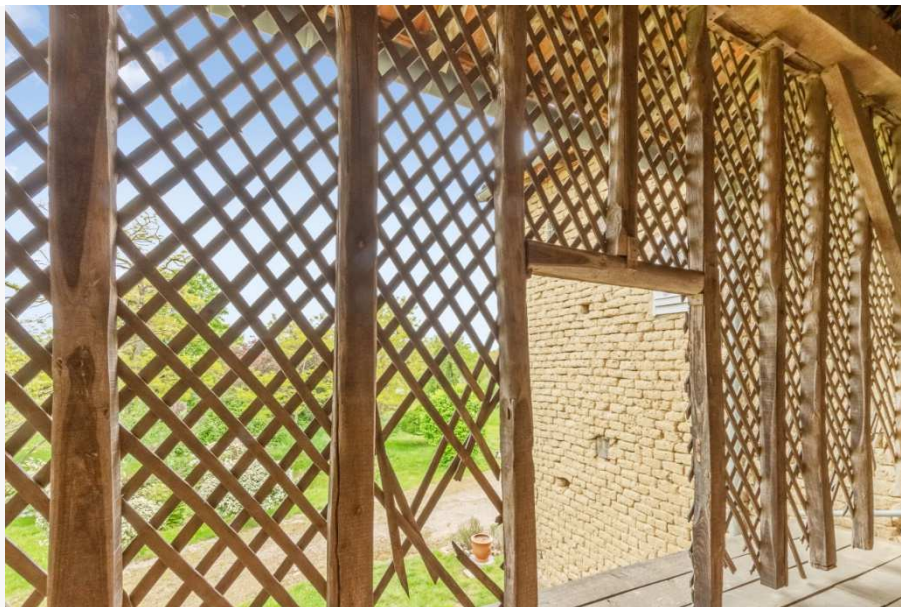
Figure 12 : Vue depuis le bâtiment adossé à l'arrière : l'étage servait de séchoir
