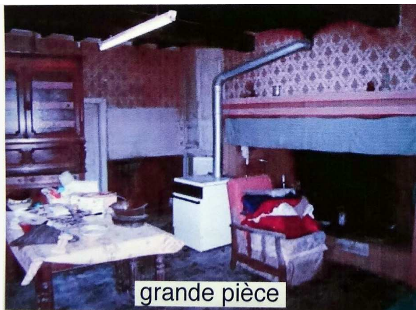
Figure 4 : Le poêle à mazout raccordé dans le conduit de la cheminée de la pièce principale (source : Fernando Gomez)
