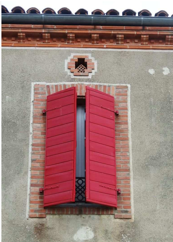
Figure 8 : L'enduit décoratif et le détail de l'appareillage des briques aux encadrements et dans la corniche
