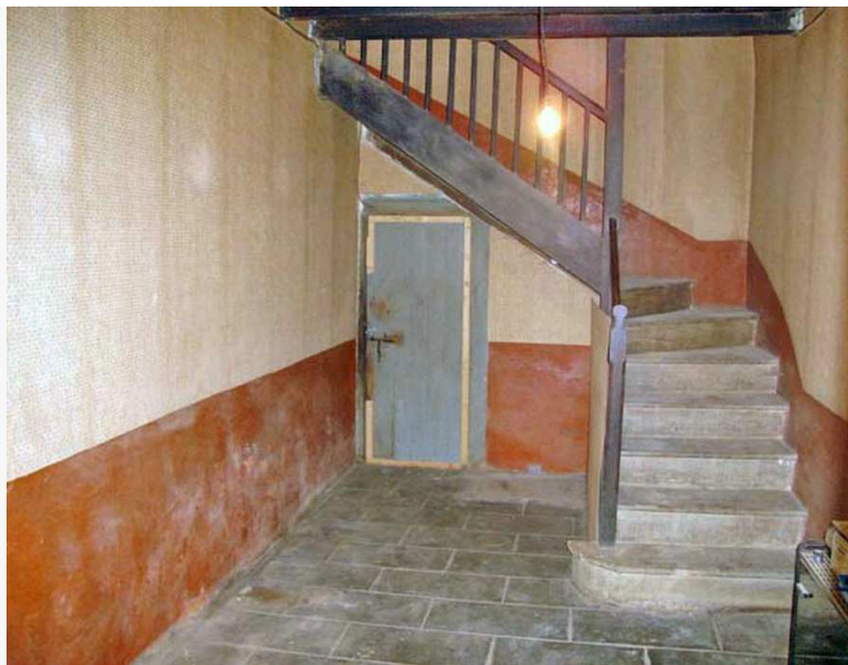
Figure 10 : Le sol en ciment dans l'entrée avant travaux (source : Fernando Gomez)
