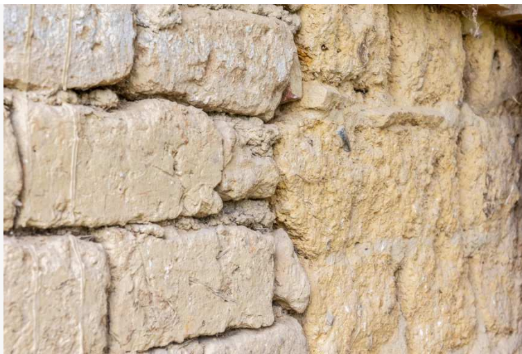
Figure 6 : Le mur en adobe de terre crue, visible dans la grange
