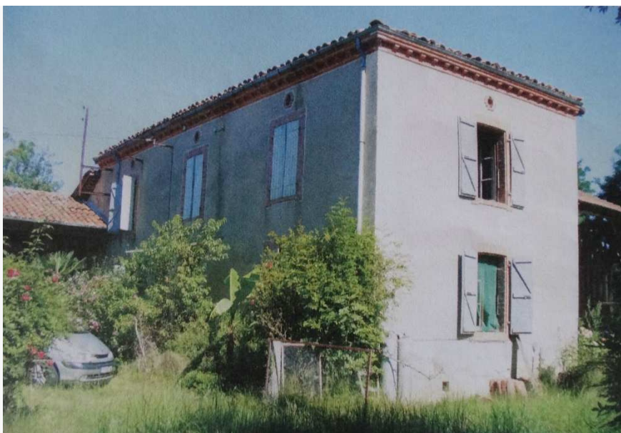
Figure 3 : La maison avant travaux (source : Fernando Gomez)
