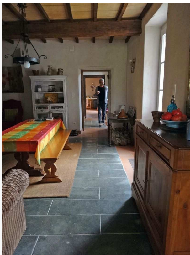
Figure 15 : Les sols de la salle à manger et l'entrée après travaux associant sol en terre cuite dans les parties périphériques isolées et sol en ciment maintenu au centre
