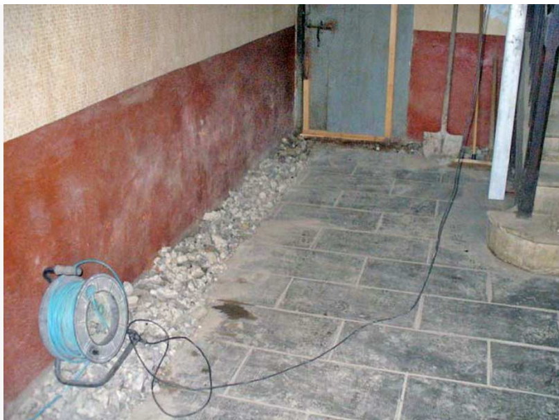
Figure 14 : Les travaux de piquage du sol en ciment dans les parties périphériques de l'entrée (source : Fernando Gomez)
