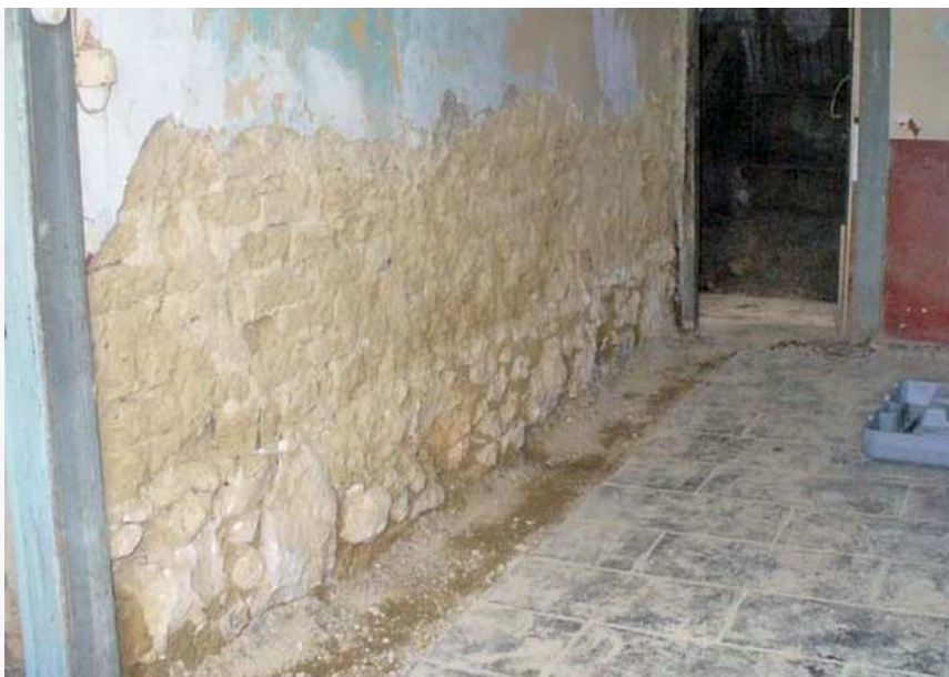
Figure 7 : La partie basse du mur maçonnée en pierre calcaire (source : Fernando Gomez)
