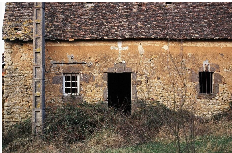
Illustration 5 : Façade sud avant restauration
