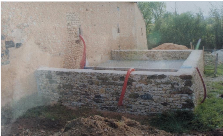
Illustration 18 : Soubassement en pierre et chape de l'extension
