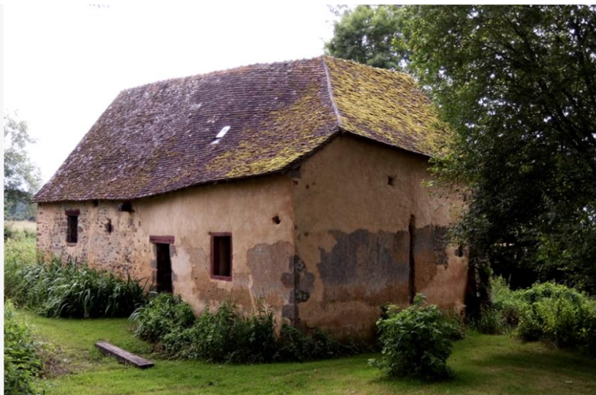
Illustration 3 :Moulin du 15 e ou du 16 e siècle (source : CREBA)
