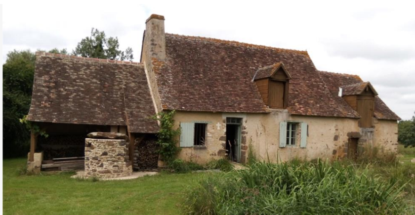
Illustration 4 : Seconde maison en cours de réhabilitation (source : CREBA)
