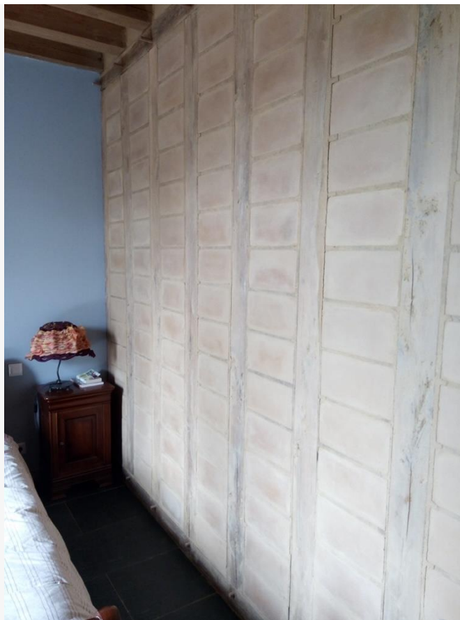
Illustration 20 : Mur intérieur en brique de terre crue (source : CREBA)
