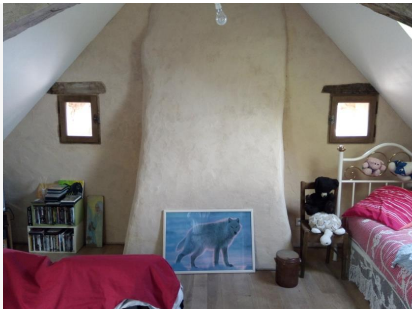
Illustration 26 : Mur façade ouest à étage (source : CREBA)
