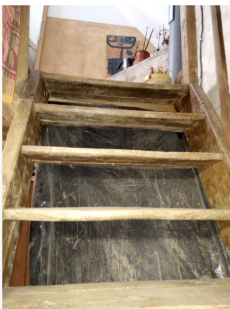
Illustration 8 : Escalier d'origine (source : CREBA)
