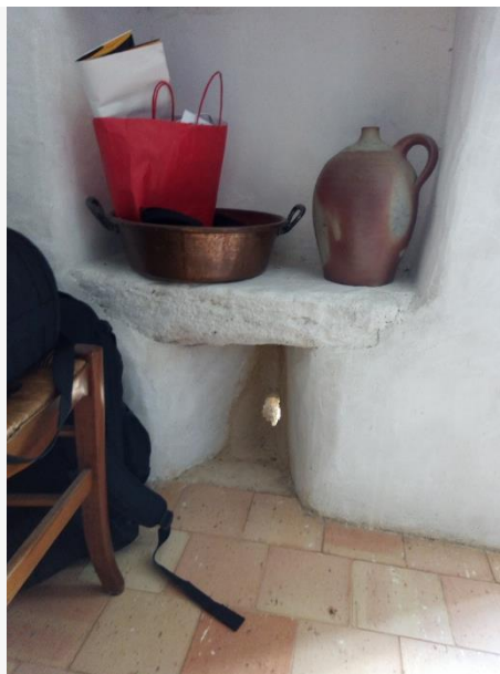
Illustration 30 : Ancienne sortie d'eau (source : CREBA)
