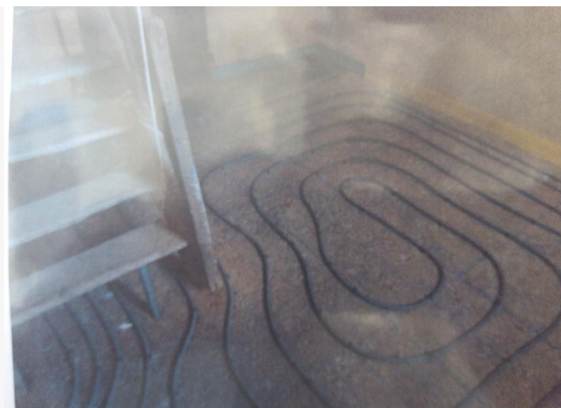
Illustration 28 : Pose des serpentins pour le plancher chauffant
