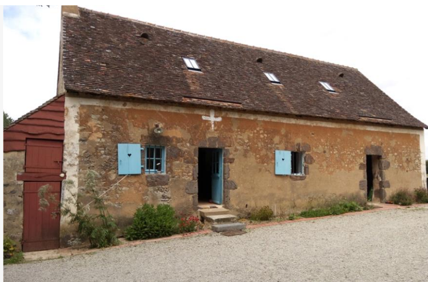
Illustration 11 : Façade sud (source : CREBA)
