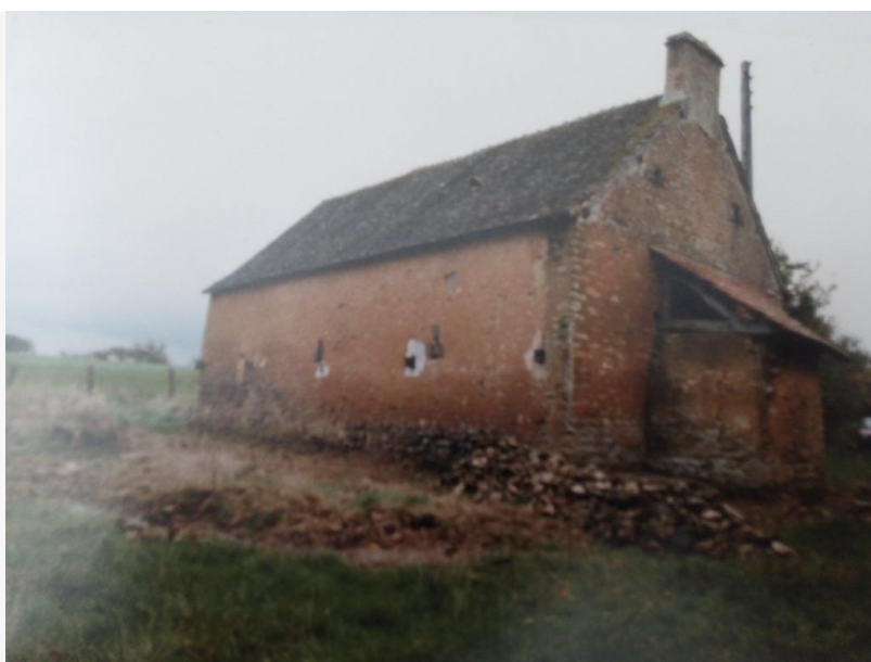
Illustration 15 : Façade ouest avant 2001
