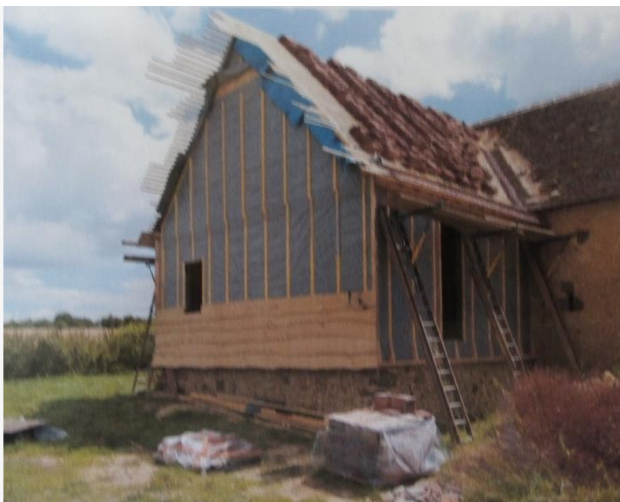
Illustration 19 : Extension en cours de construction
