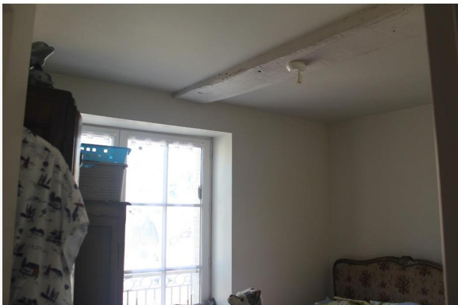
Figure 18 : Nouvelle menuiserie, vue intérieure avec sommier arrivant en milieu d'ouverture
