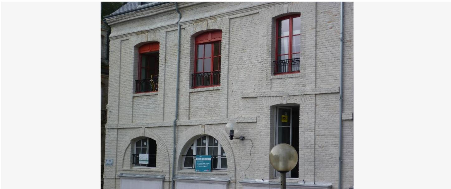
Figure 19 : Nouvelle menuiserie, vue extérieure, peinture en cours de réalisation (source : M. Cheval)
