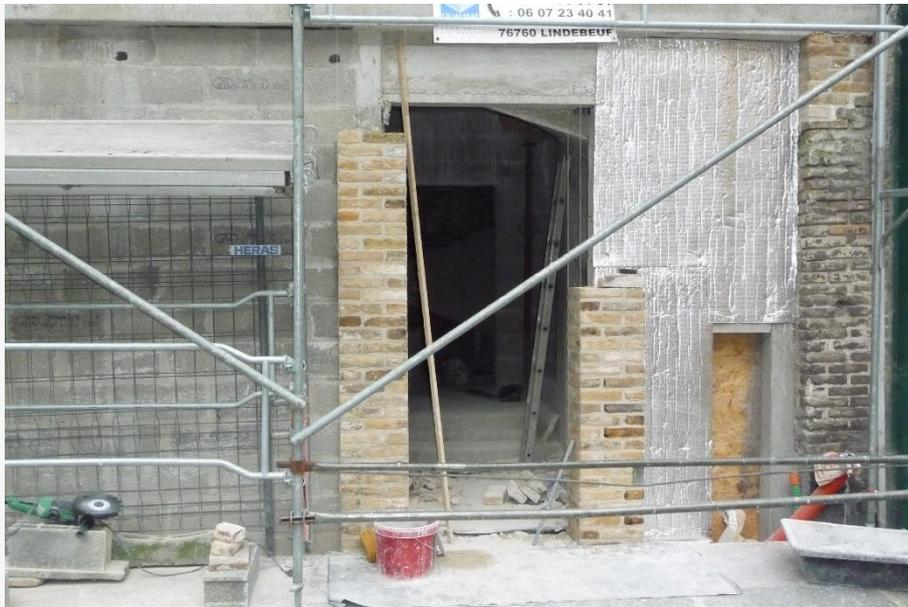
Figure 13 : Insertion de briques de réemploi en parement de l'extension neuve (source : M. Cheval)
