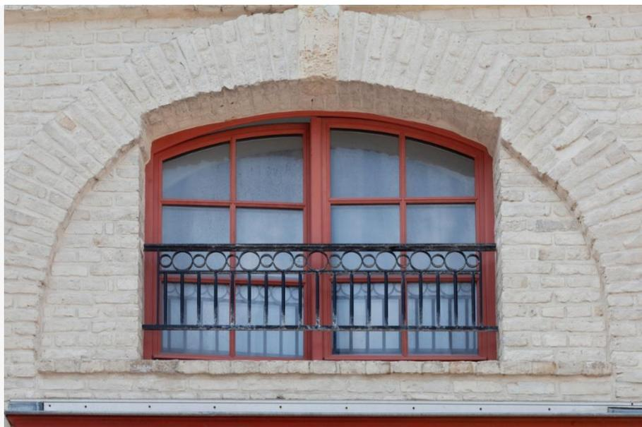
Figure 4 : Arcade de l'entresol et peinture à la chaux sur la brique
