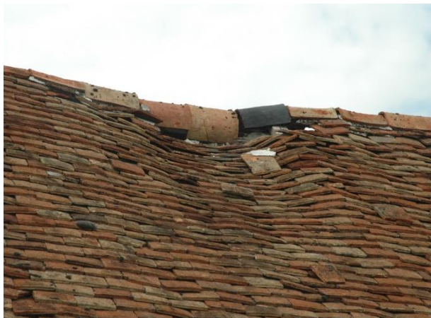
Figure 4 : Des failles dans la couverture et au niveau de la corniche
