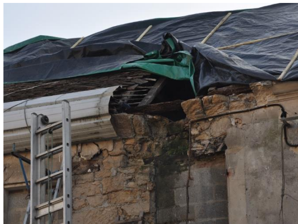
Figure 4 : Des failles dans la couverture et au niveau de la corniche
