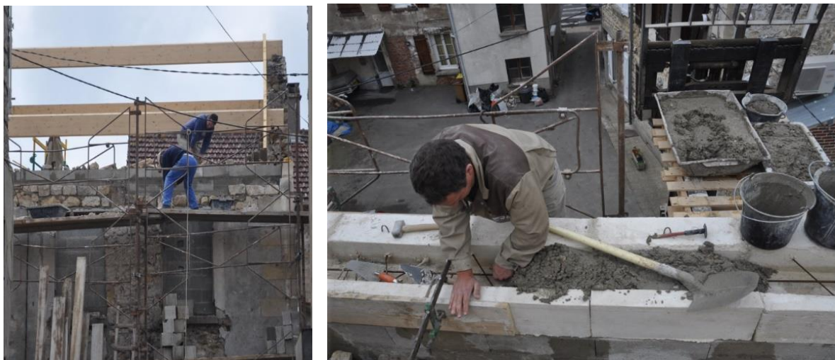
Figure 8 Consolidation de la structure et reprise de l'arase avant pose de la charpente
