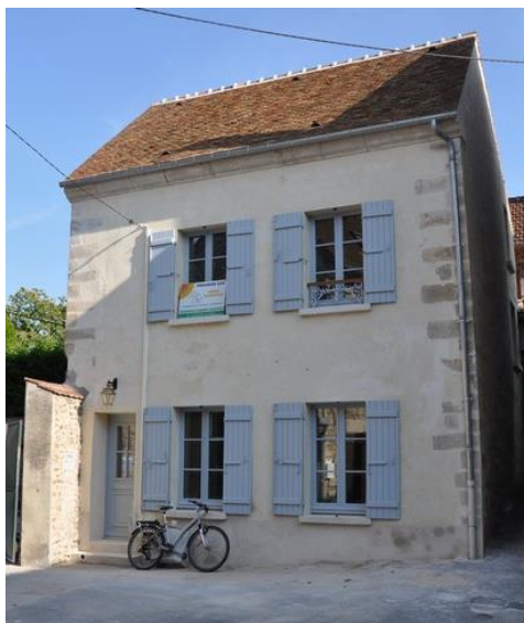
Figure 21 : Vue après travaux
