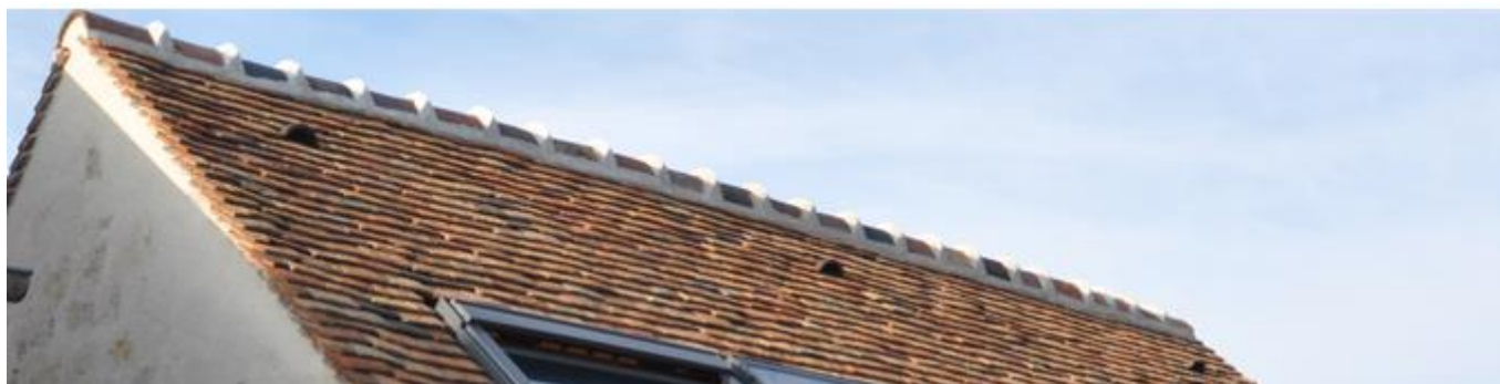
Figure 15 Tuiles plates et crêtes de coq sont de rigueur
