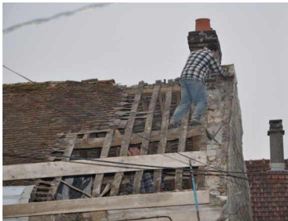
Figure 7 Déconstruction du toit et récupération des tuiles
