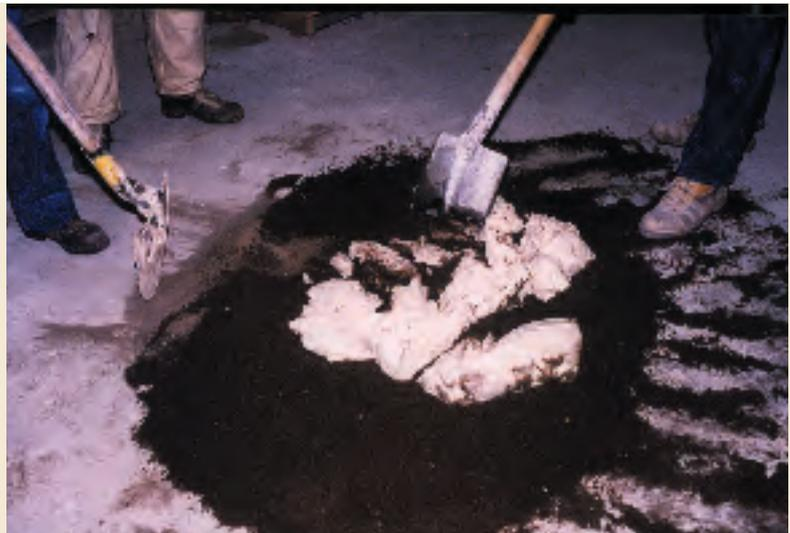
Fabrication d'un mortier sable et chaux
