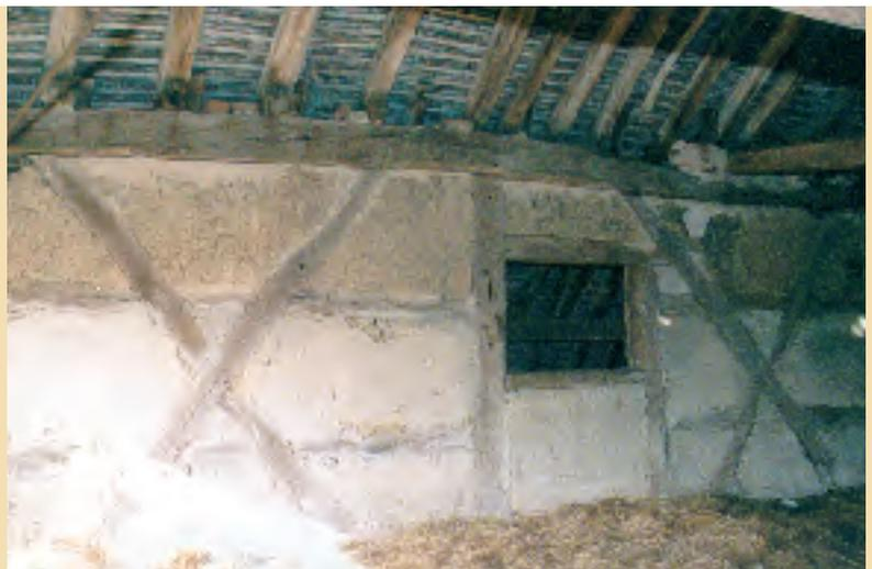
Pan de bois, torchis d'argile et paille, recouvert d'enduit à la chaux
