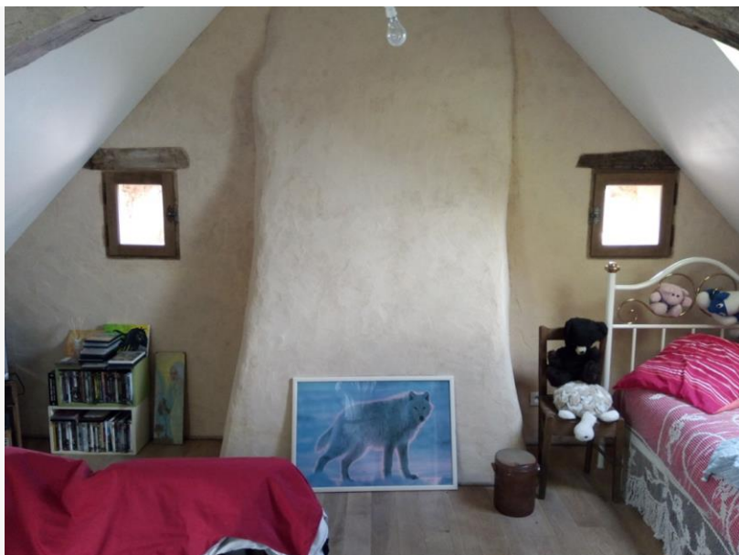
Illustration 26 : Mur façade ouest à étage (source : CREBA)
