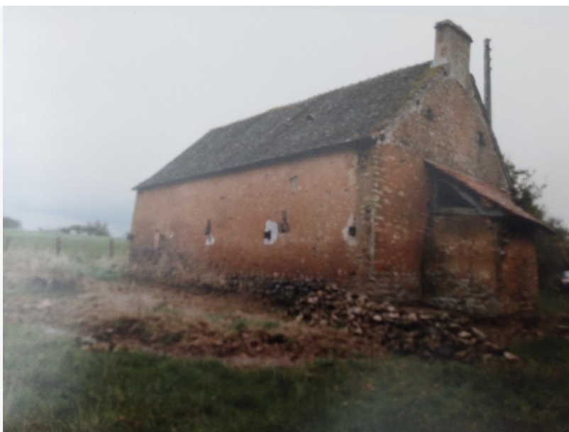
Illustration 15 : Façade ouest avant 2001
