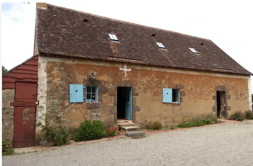
Illustration 11 : Façade sud (source : CREBA)
