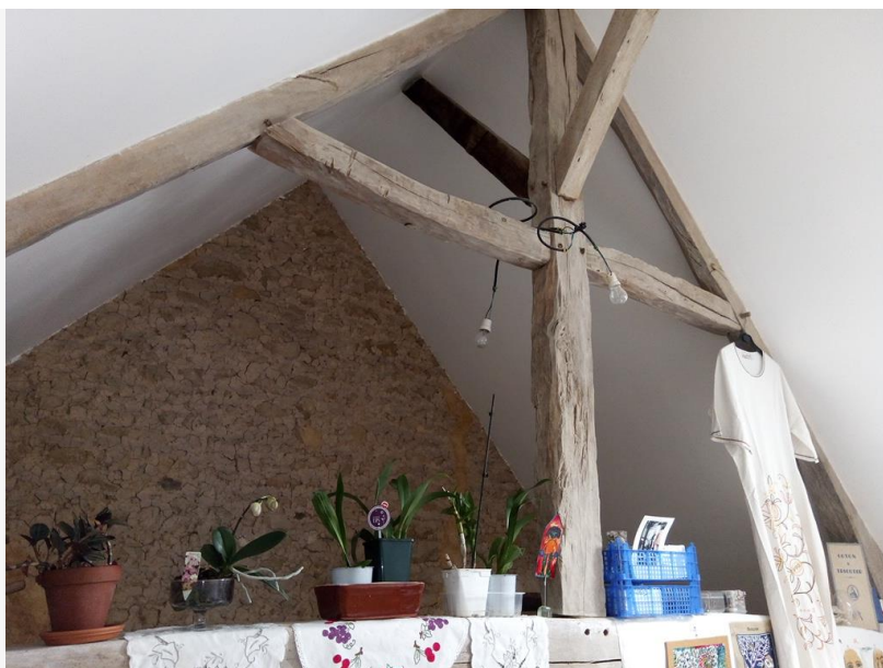
Illustration 23 : Grenier et mur de la façade est (source : CREBA)
