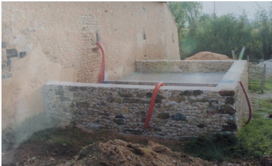
Illustration 18 : Soubassement en pierre et chape de l'extension
