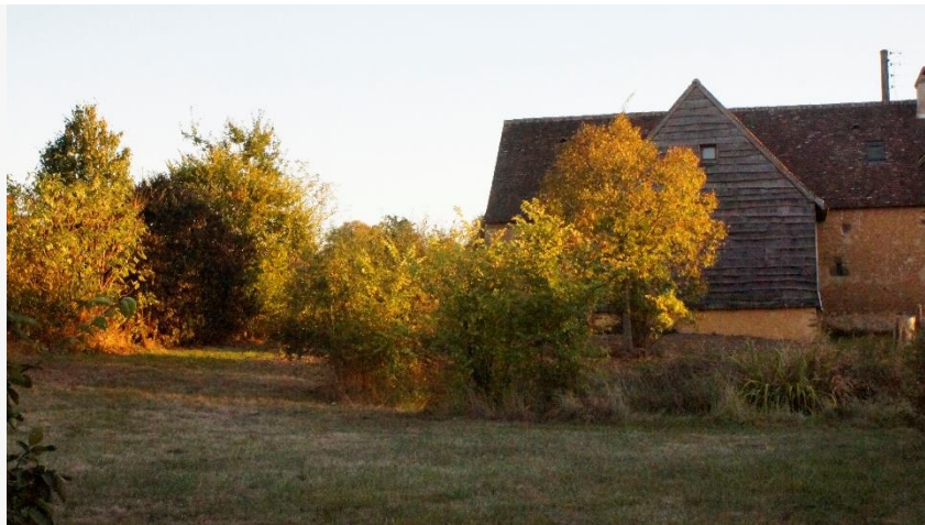
Illustration 12 : Extension à l'arrière de la maison (source : CREBA)
