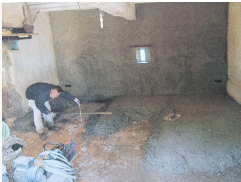
Illustration 27 : Pose des couches d'enduit chaux-chanvre murs et sol dans le séjour (rez-de-chaussée)
