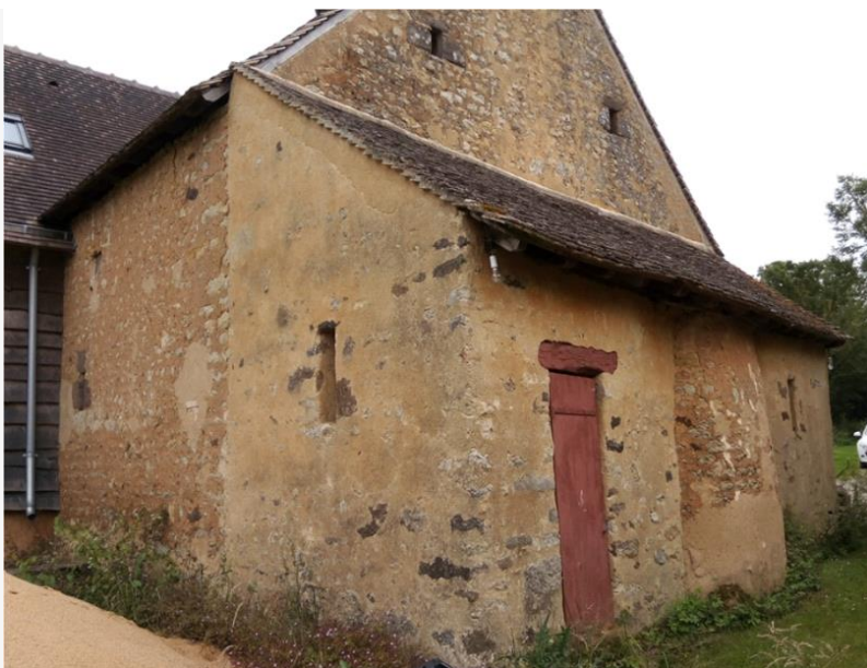
Illustration 16 : Les deux locaux reconstruits après 2001 (source : CREBA)
