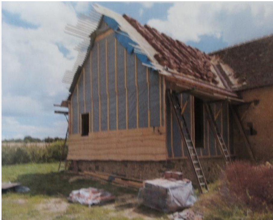
Illustration 19 : Extension en cours de construction
