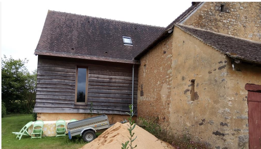
Illustration 17 : Façade ouest de l'extension (source : CREBA)
