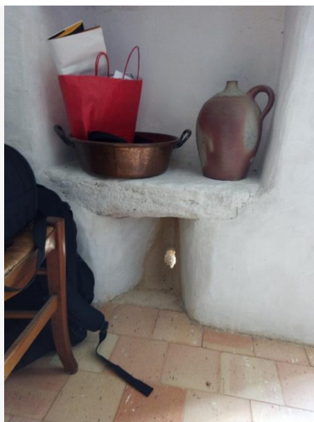
Illustration 30 : Ancienne sortie d'eau (source : CREBA)
