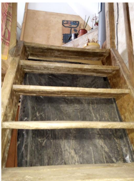
Illustration 8 : Escalier d'origine (source : CREBA)
