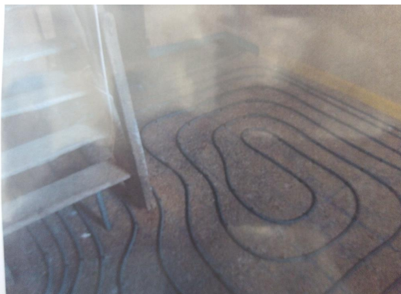
Illustration 28 : Pose des serpentins pour le plancher chauffant
