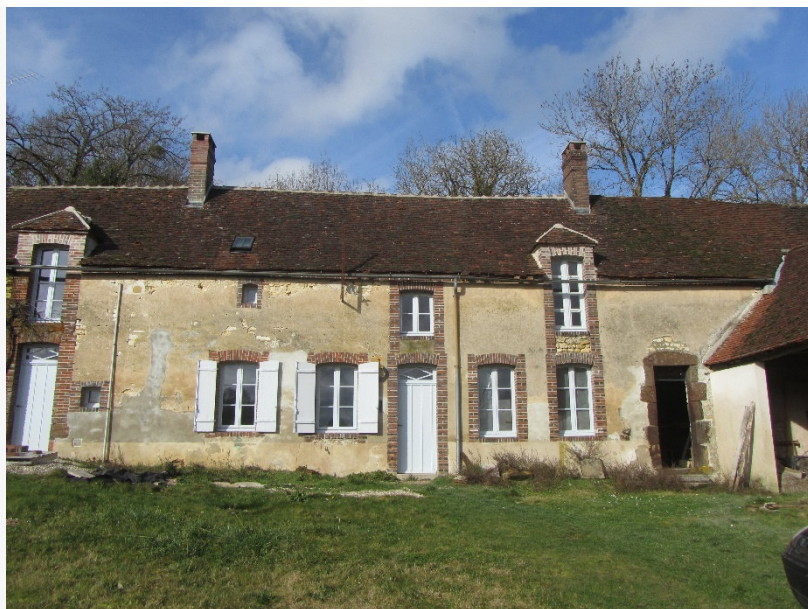
Figure 1 : Façade sud de la maison (source : CREBA)
