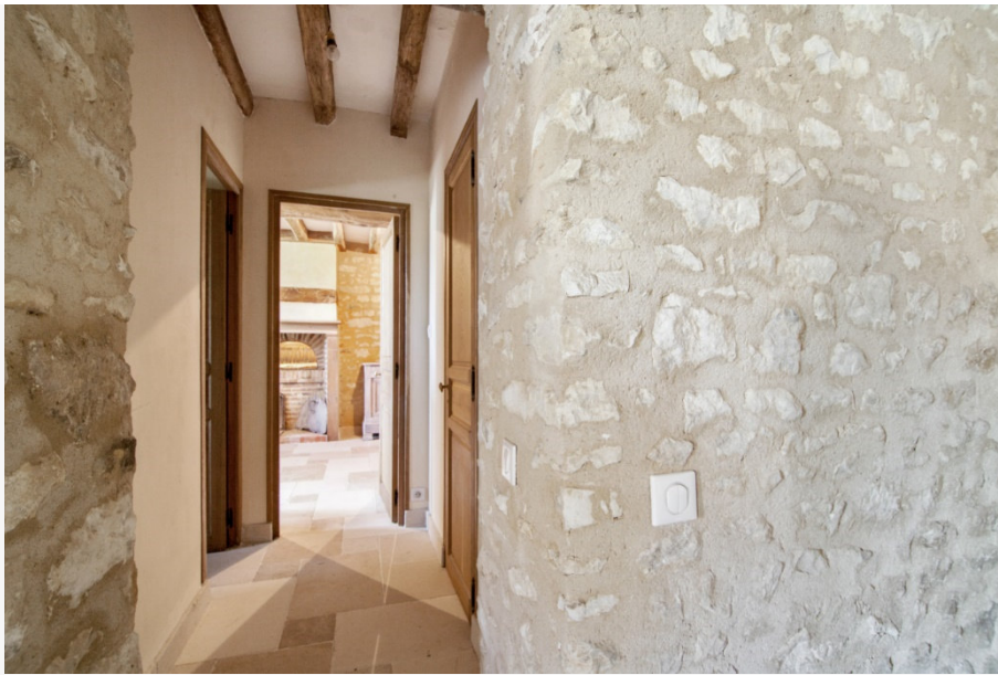
Figure 9 : Murs de refend intérieur (source : CREBA)
