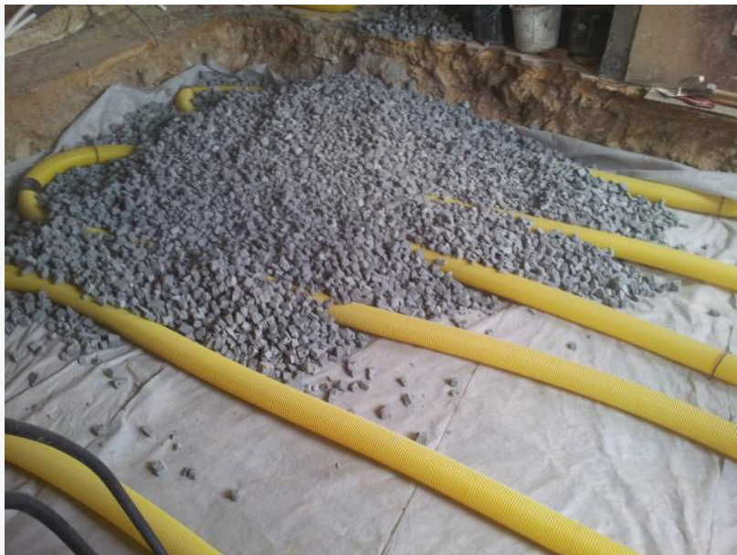
Figure 19 : Drains ventilés et hêrisson
