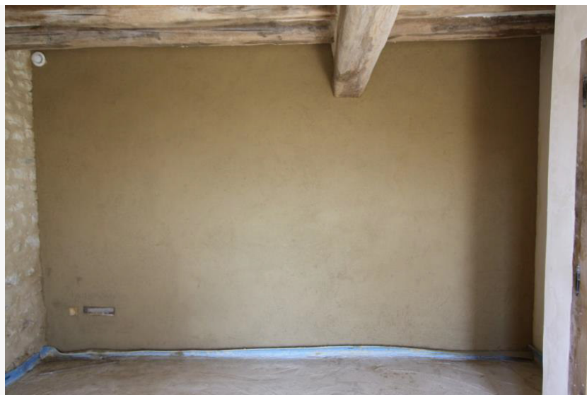
Figure 16 : Mur nord avec enduit de terre 20 mm
