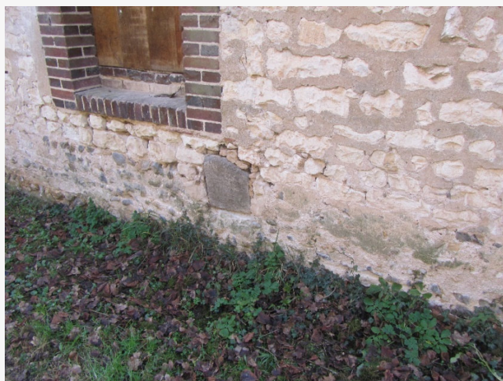
Figure 38 : La poutre en question est visible de l'extérieur sur la façade nord (source : CREBA)
