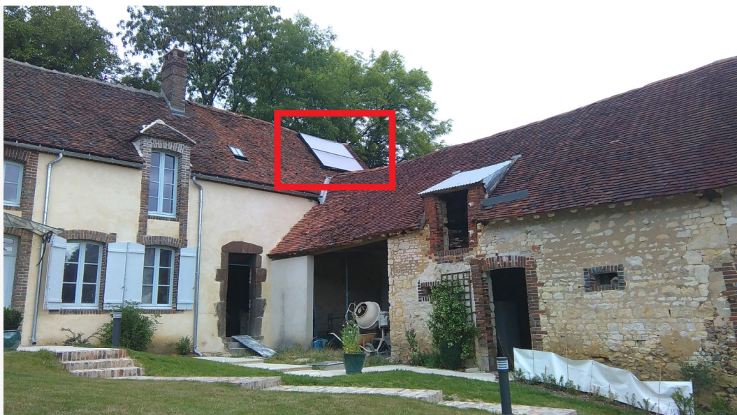
Figure 32 : Façade sud maison, avec les panneaux solaires (carré rouge)
