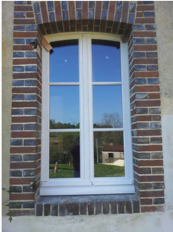
Figure 21 : Menuiseries bois double vitrage
