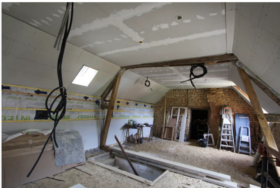
Figure 17 : Etage isolé et doublé
