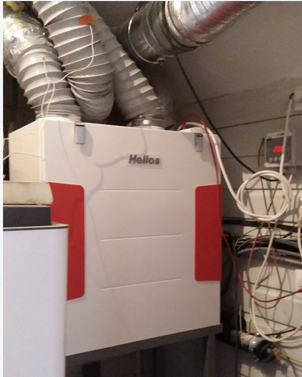
Figure 34 : Echangeur VMC DF (source CREBA)
