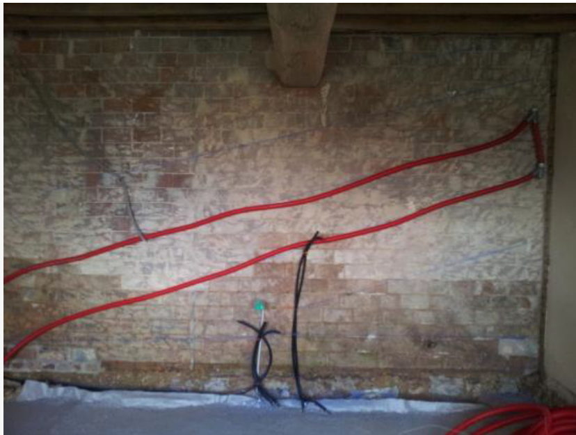
Figure 13 : Drain mural avant la pose de l'enduit
