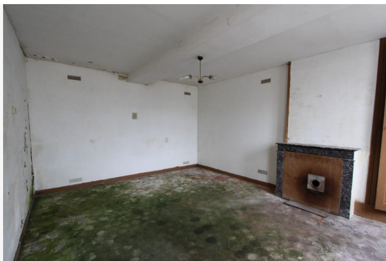
Figure 3 : Sol du rez-de-chaussée
