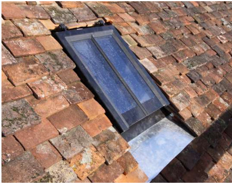
Figure 22 : Châssis à tabatière remplacés
