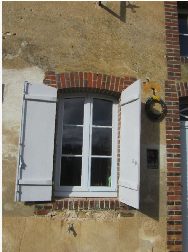
Figure 23 : Volets neufs fabriqués à l'ancienne (source : CREBA)
