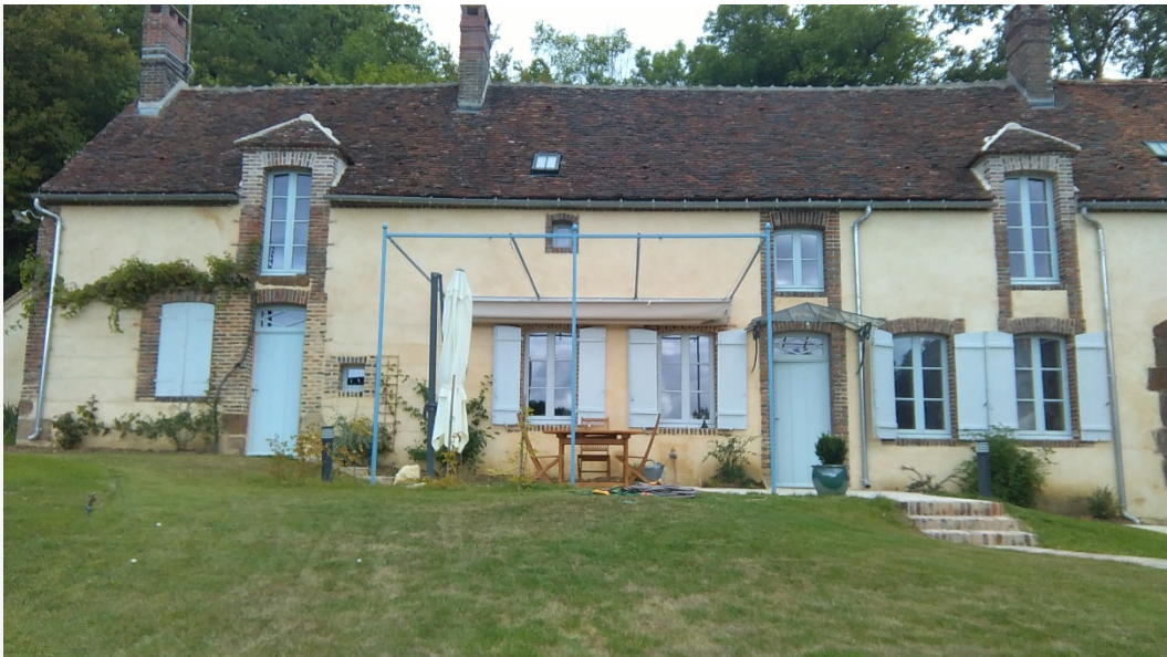
Figure 15 : Façade sud ré-enduite chaux-sable
