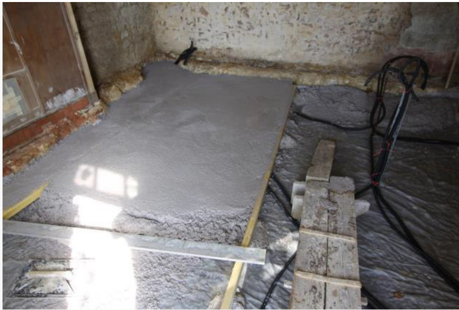
Figure 20 : Dalle de chaux/pouzzolane
