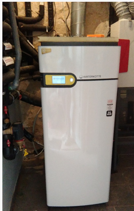
Figure 27 : Pompe à chaleur eau-eau (source : CREBA)
