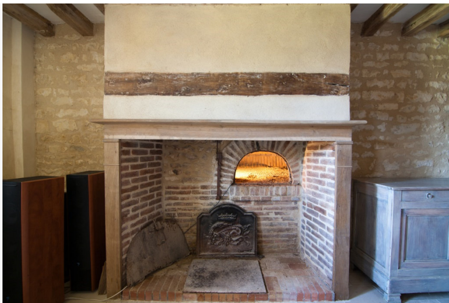
Figure 5 : Entrée du four à pain (source : CREBA)
