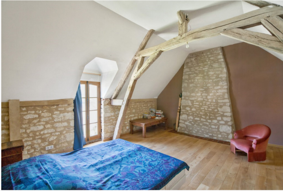
Figure 24 : Cheminée et murs en pierres apparentes, charpente apparente (source : CREBA)
