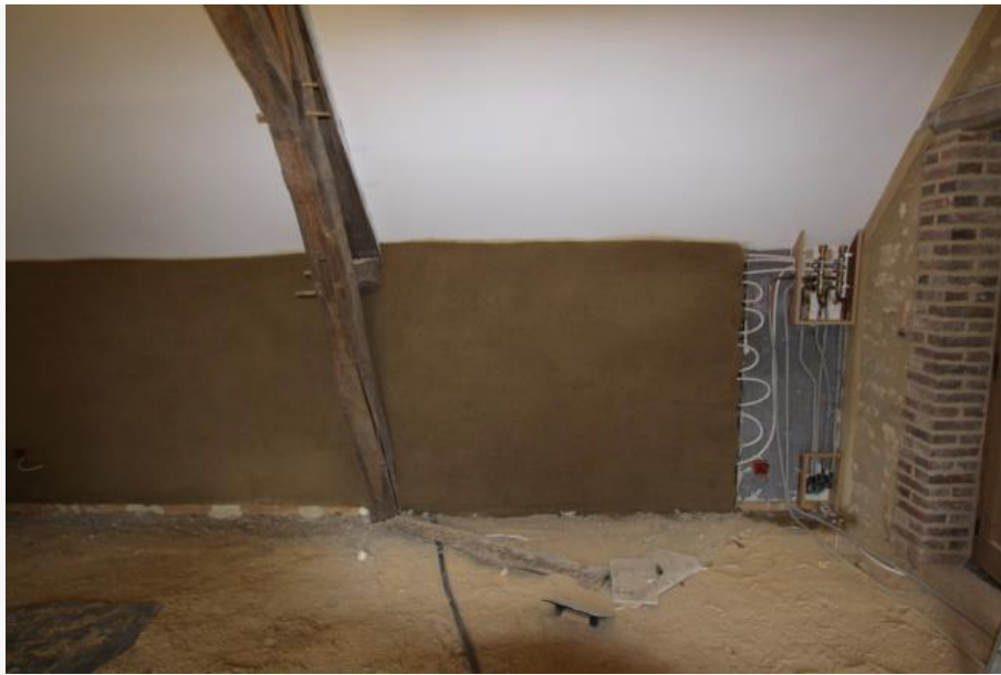
Figure 30 : Mur chauffant derrière enduit terre
