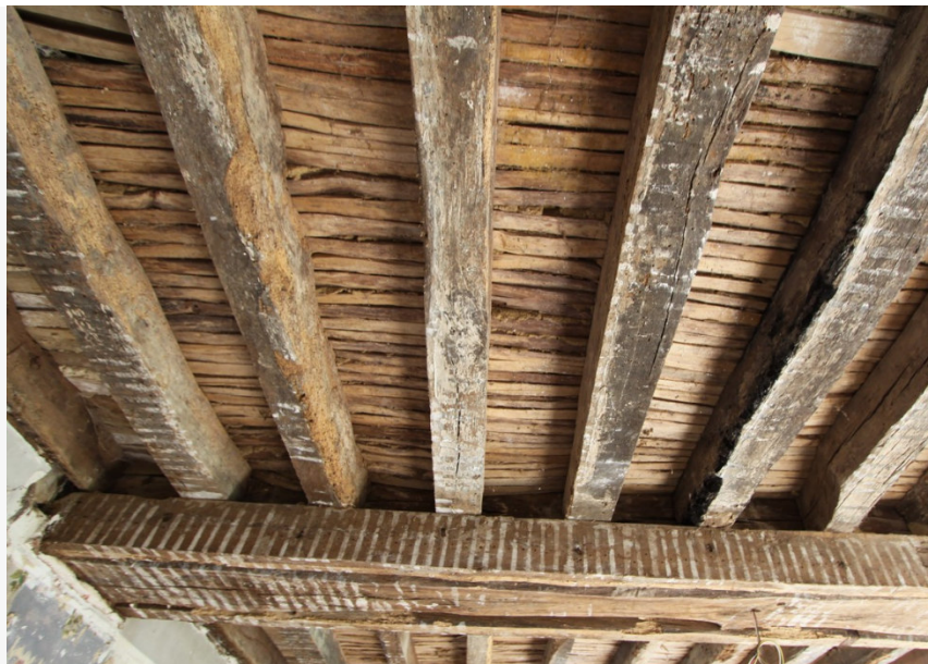
Figure 10 : Solives en chêne et lattes fendues en châtaignier
