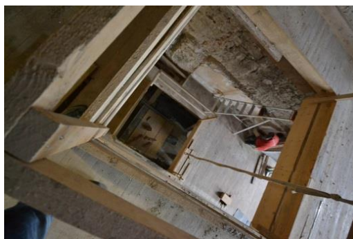
Figure 7 Trémie ascenseur
