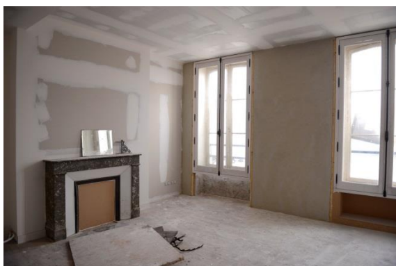
Enduits chaux chanvre, redressement mitoyen
