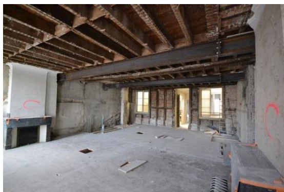
Figure 8 Sol et renforts plancher au 1er étage
