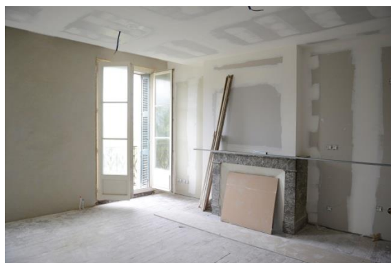
Enduits chaux chanvre, redressement mitoyen
