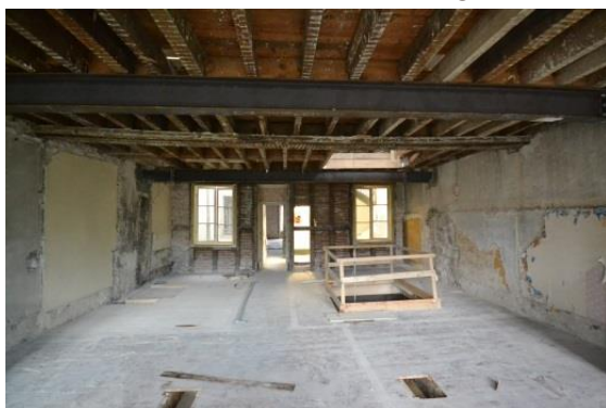
Figure 8 Sol et renforts plancher au 1er étage
