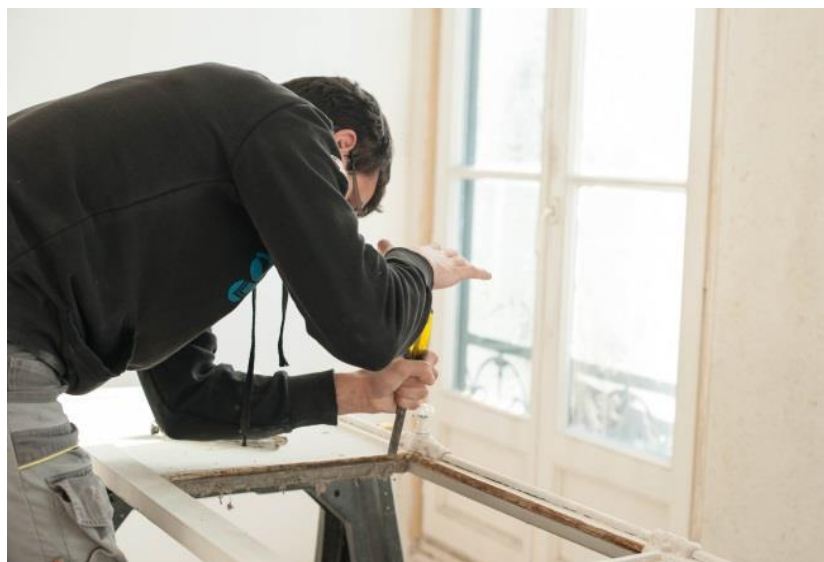
Figure 9 Ajustage et mise en jeu menuiseries Sud conservées
