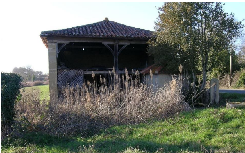
Figure 2 Façade est de la grange
