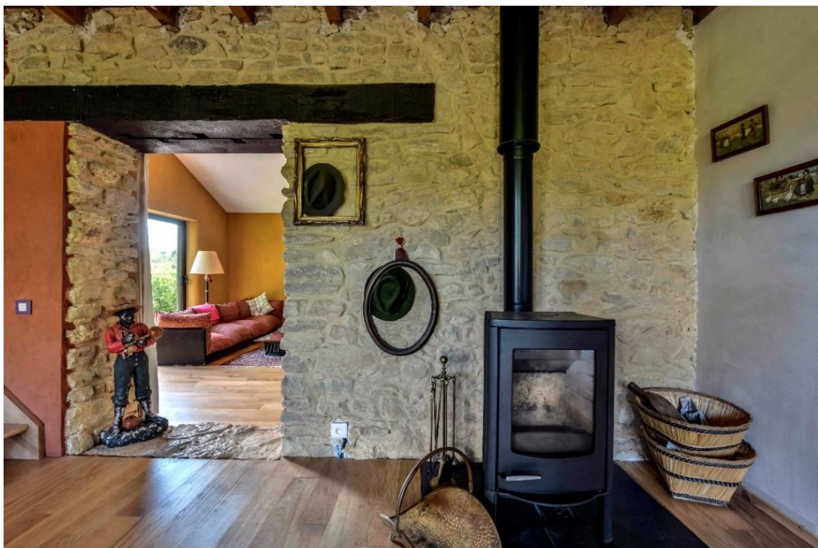
Figure 17 : Ouverture après travaux, avec mur en pierre et linteau bois apparent
