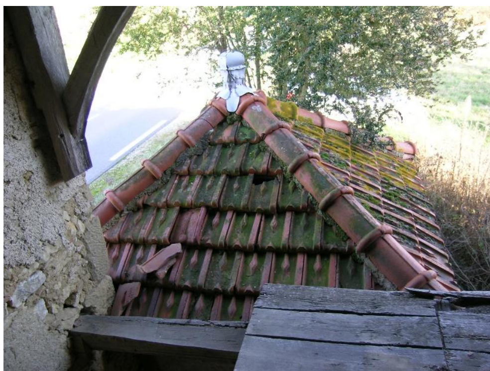
Figure 7 : Vue sur la toiture de l'édicule
