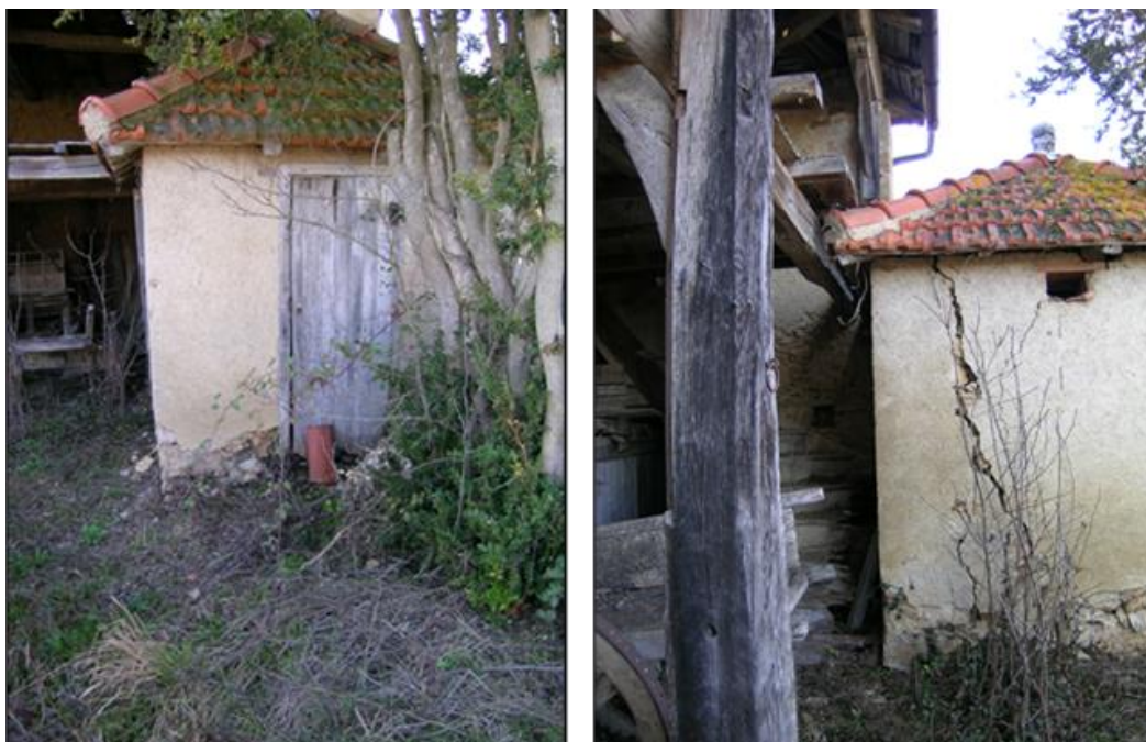
Figure 6 : Édicule situé en façade est
