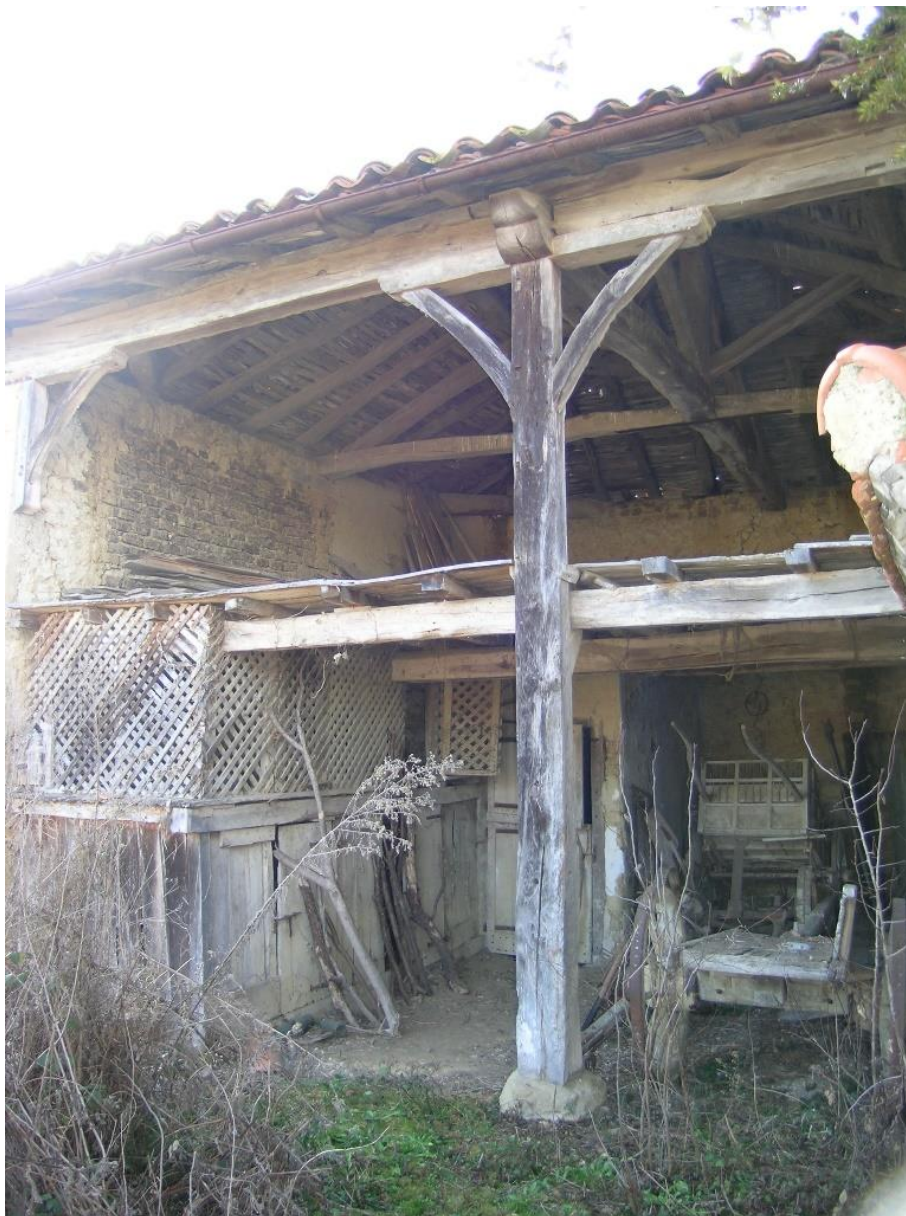
Figure 10 : La charpente en croix soutenue par un pilier central coté est.
