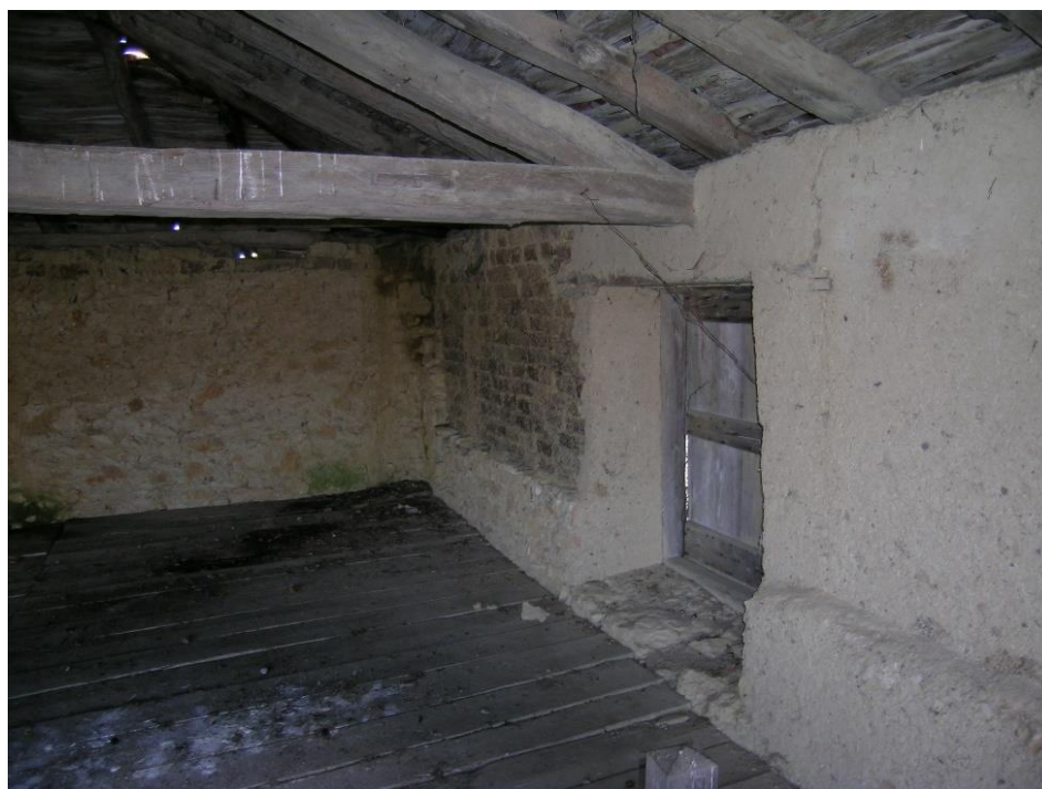
Figure 9 : Plancher haut en châtaigner
