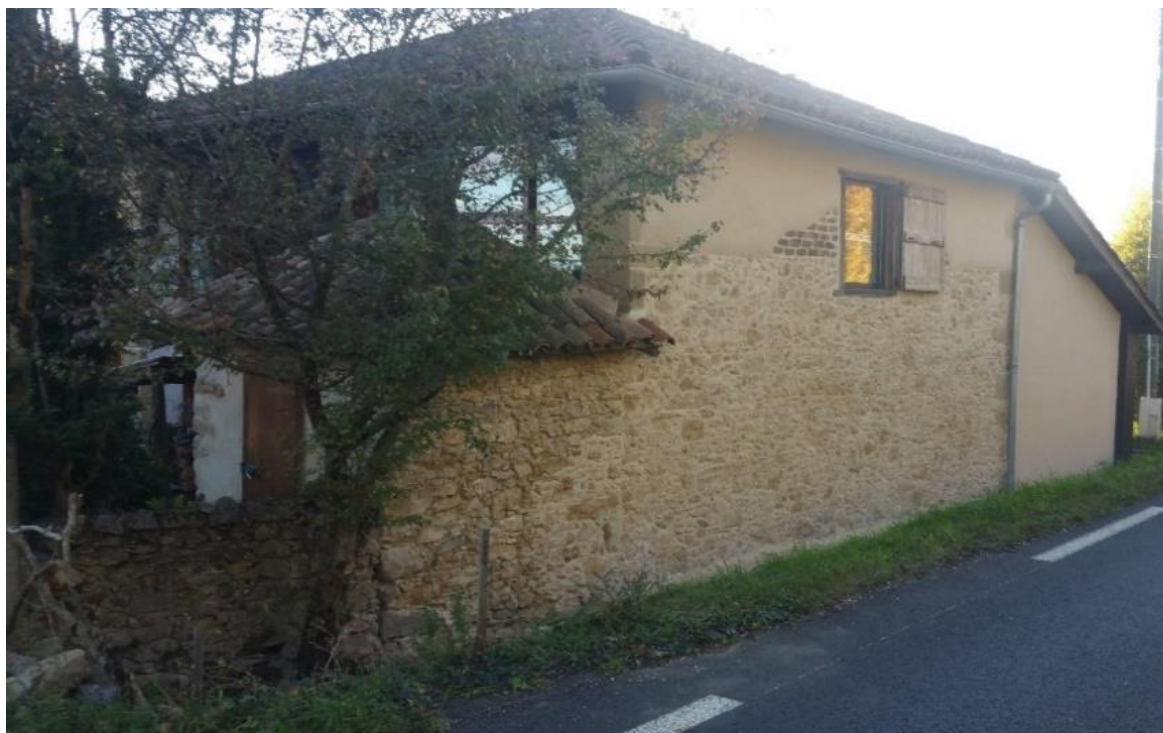
Figure 14 : Vue sur le mur nord après travaux
