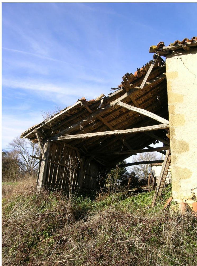
Figure 5 : État de l'appentis avant travaux
