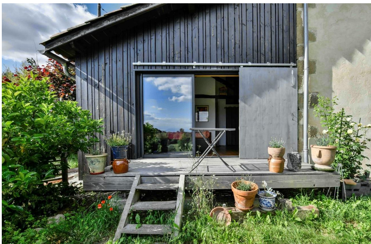
Figure 12 : Vue de la façade sud de l'extension.
