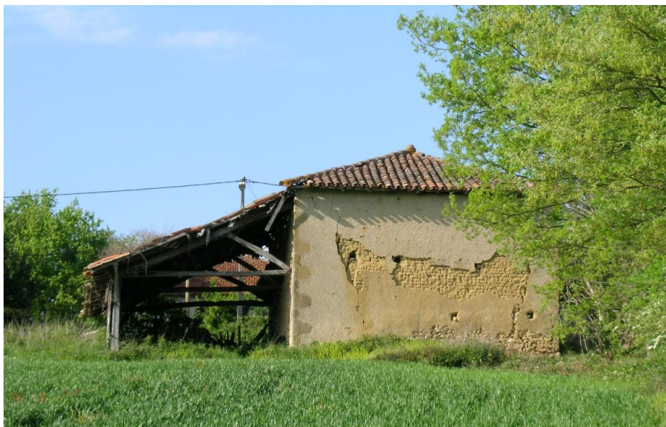
Figure 3 : Façade sud avec appentis situé à l'ouest
