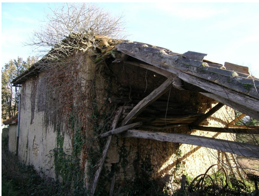
Figure 4 : Façade nord avec ouverture permettant d'atteindre l'étage
