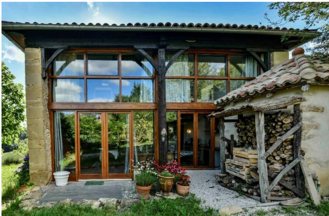
Figure 16 : Façade est de la grange après travaux
