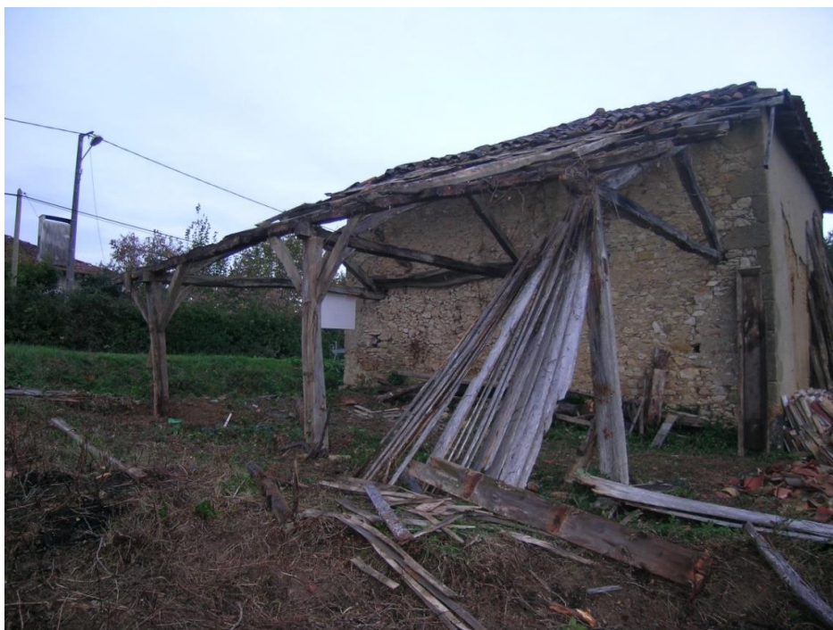
Figure 11 : Appentis en cours de démolition
