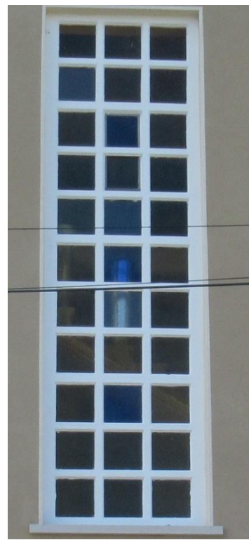
Figure 28: Mise en valeur de la verrière (source : Cerema)
