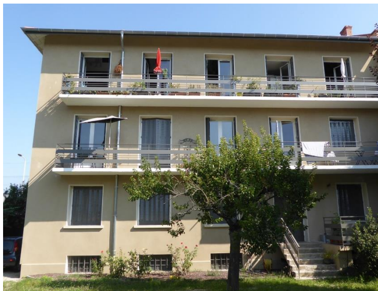
Figure 19: Enduit sur la façade sud (Source : Cerema)
