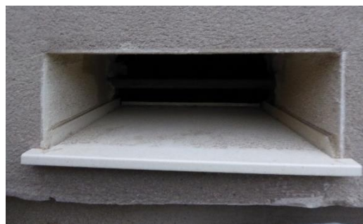
Figure 34: Soupirlail coté extérieur (Source : Cerema)
