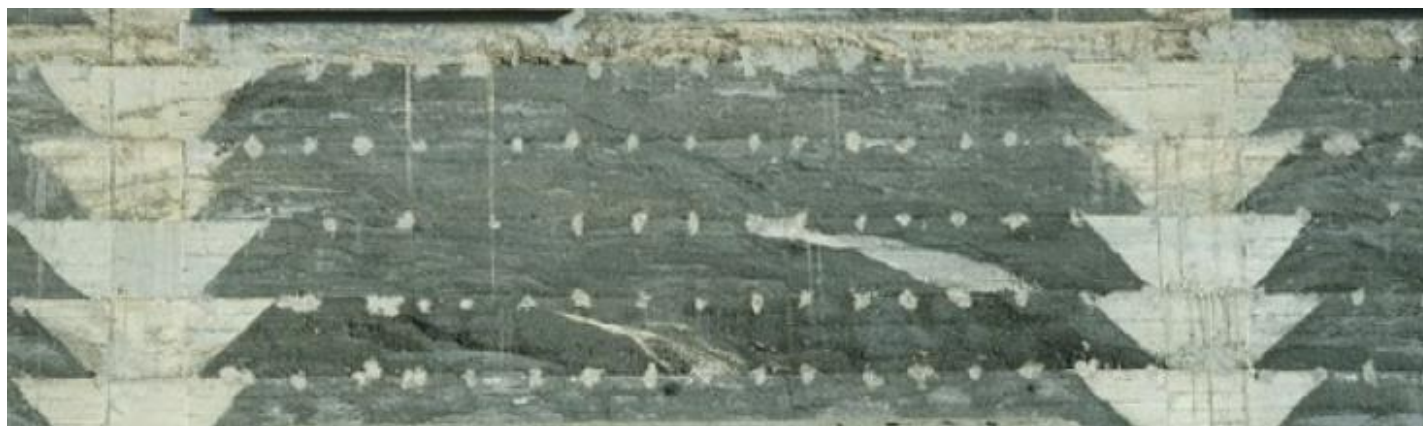
Figure 13: Façade d'un bâtiment industriel en pisé de mâchefer à Villeurbanne: on distingue les chainages et les couches successives (avec les empreintes des banches et les trous rebouchés des clés qui maintiennent les banches pendant le tassement du matériau au psoir)
