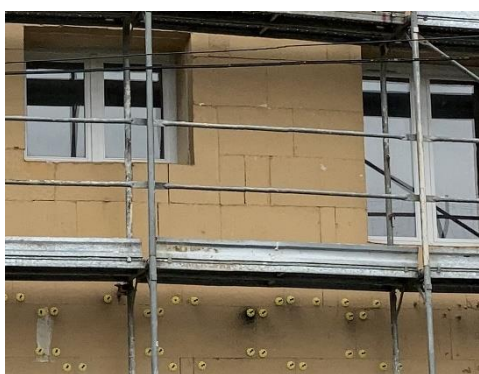
Figure 20: Pose des panneaux de fibre de bois
