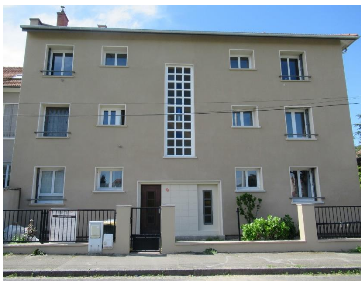
Figure 18 : Façade nord isolée par l'extérieur (Source : André Charron)
