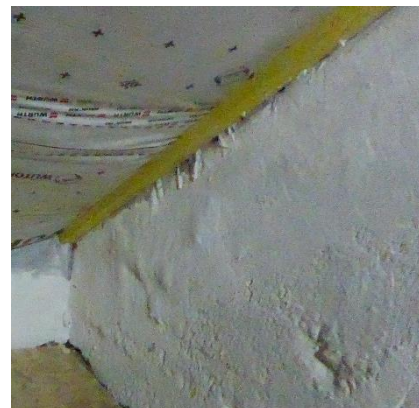
Figure 31: bord du frein vapeur marouflé au plâtre (Source : Cerema)
