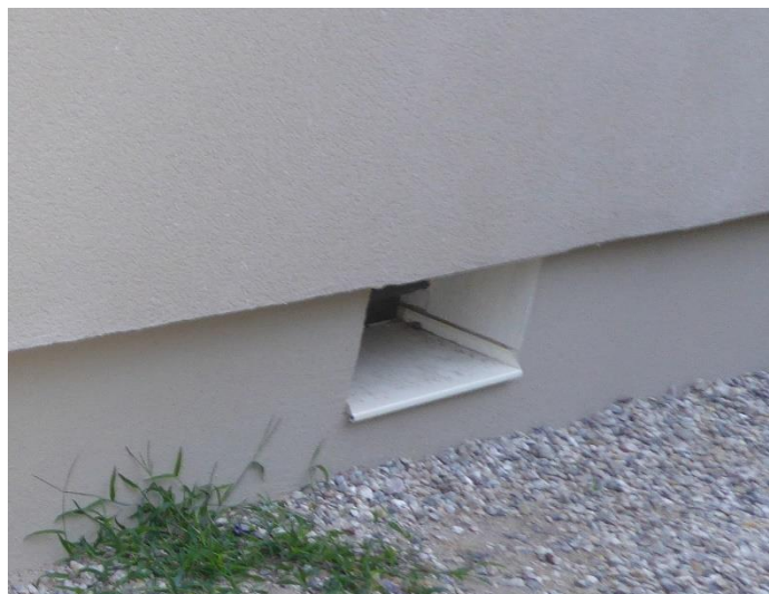
Figure 22 : Traitement du soubassement pour limiter le décalage dû à l'isolation du mur
