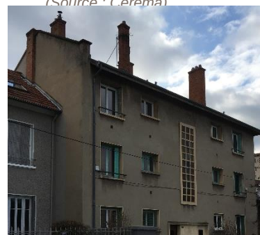
Figure 15: Cheminées de grande hauteur
