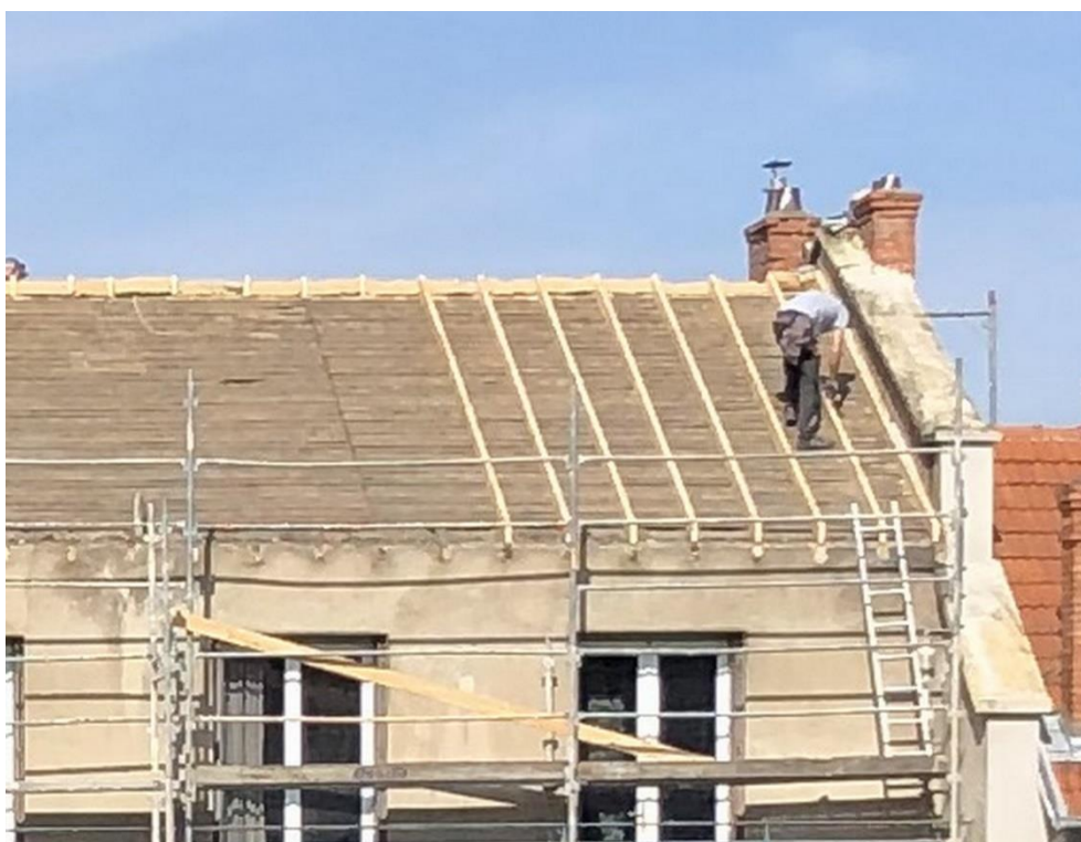
Figure 23: Isolation de la toiture par sarking
