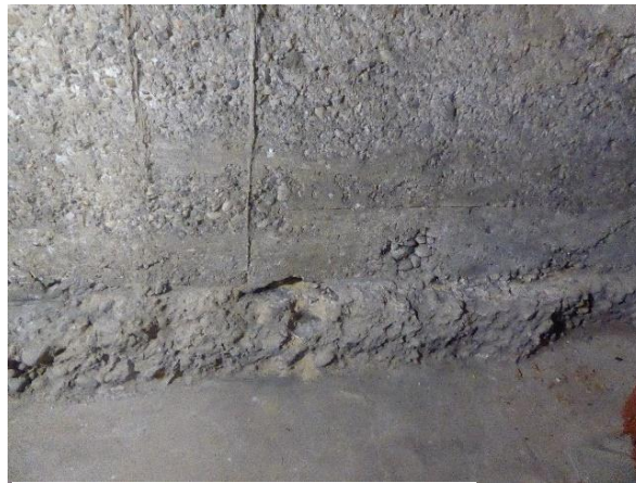
Figure 8: Sous-sol en béton de gros gravier (Source : Cerema)
