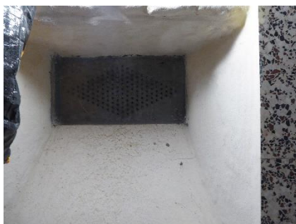
Figure 33: Soupirlail dans les caves (Source : Cerema)
