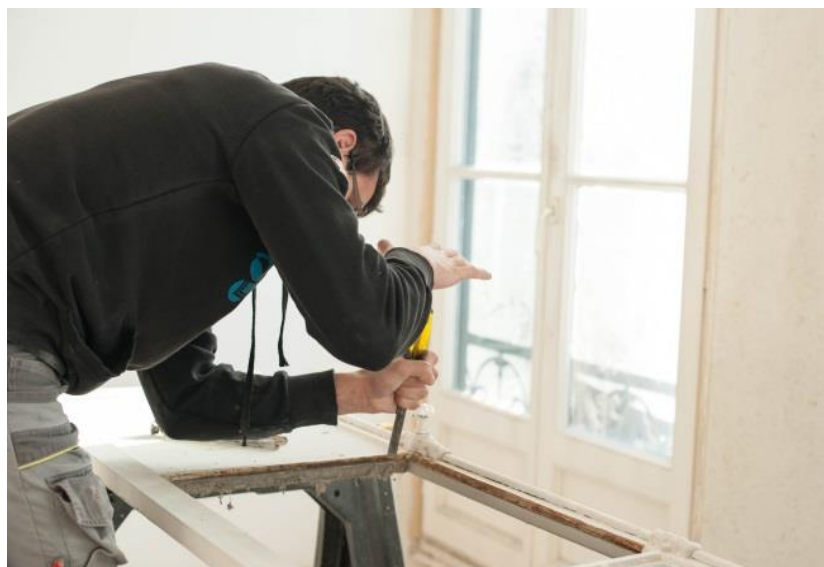
Figure 9 Ajustage et mise en jeu menuiseries Sud conservées
