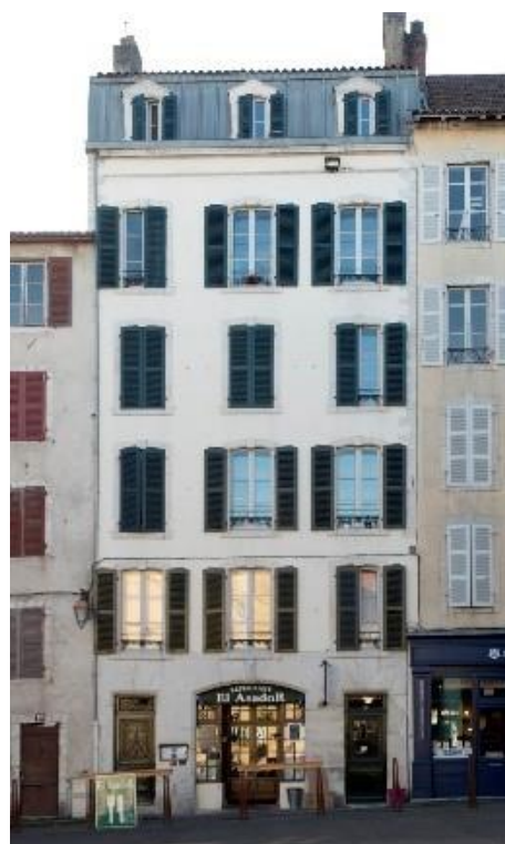
Vue de la façade Nord à 6 niveaux
