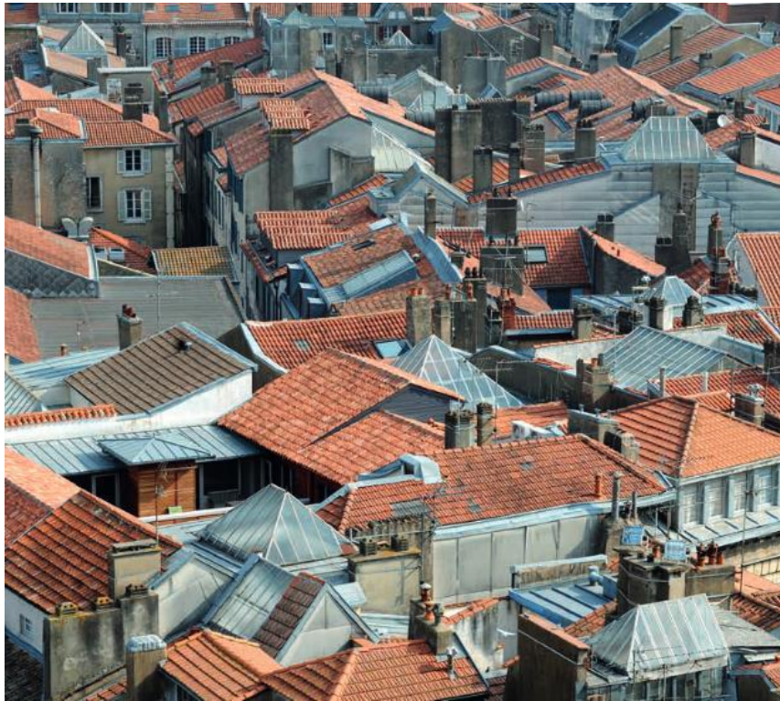
Figure 1 Vue sur les toits et les verrières de Bayonne
