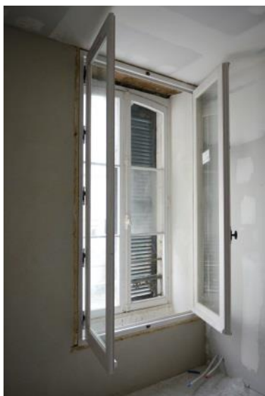
Figure 10 Double menuiserie côté Nord
