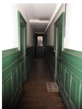
Couloir d'accès sud lambrissé
