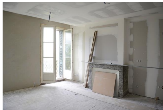
Enduits chaux chanvre, redressement mitoyen
