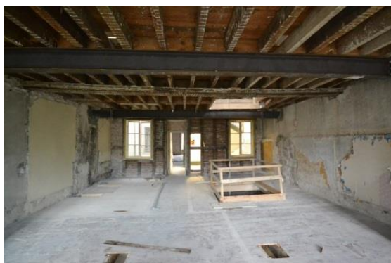
Figure 8 Sol et renforts plancher au 1er étage
