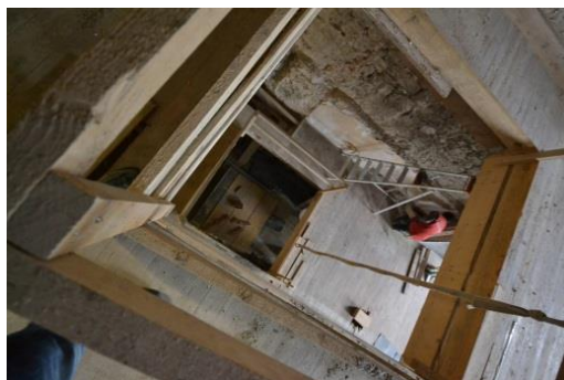
Figure 7 Trémie ascenseur
