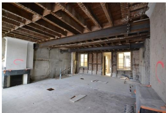
Figure 8 Sol et renforts plancher au 1er étage
