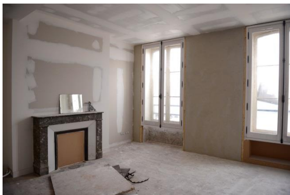
Enduits chaux chanvre, redressement mitoyen
