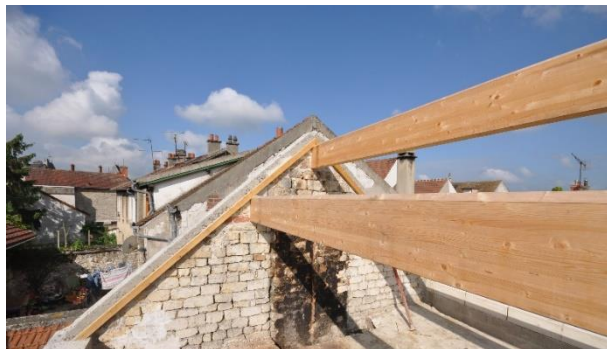
Figure 11 Le volume du dernier étage, plus vaste grâce aux poutres en lamellé- collé
