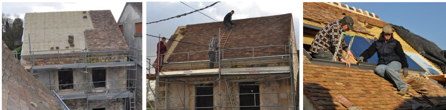
Figure 14 Pose des tuiles plates aux couleurs orangées
