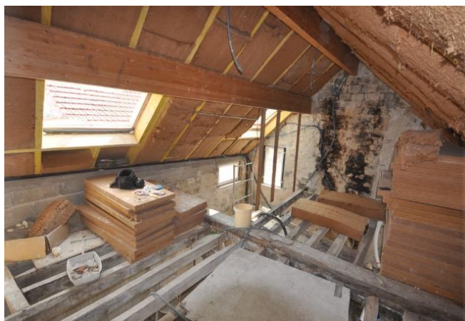
Figure 17 Pose des panneaux de laine de bois côté intérieur de la charpente
