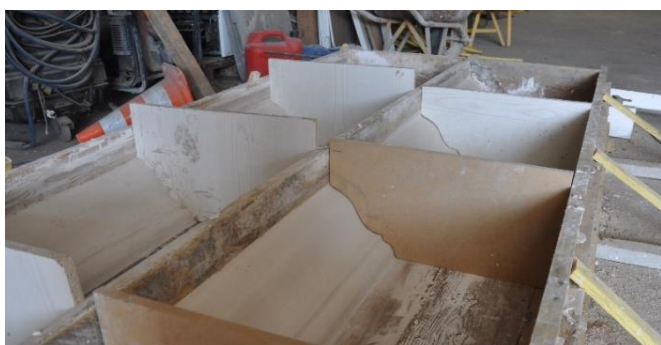
Figure 9 Le moule à plâtre pour la corniche
