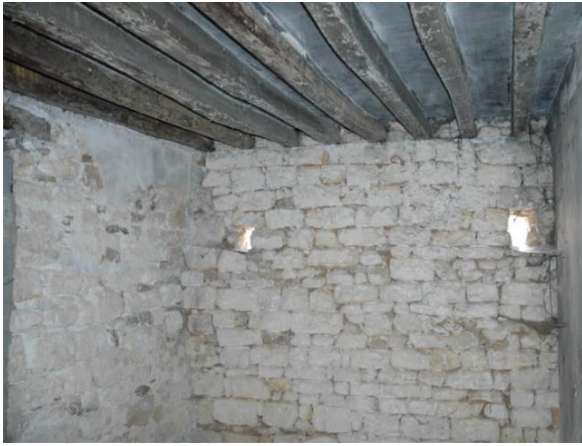
Figure 6 Murs en pierres en bon état à conserver
