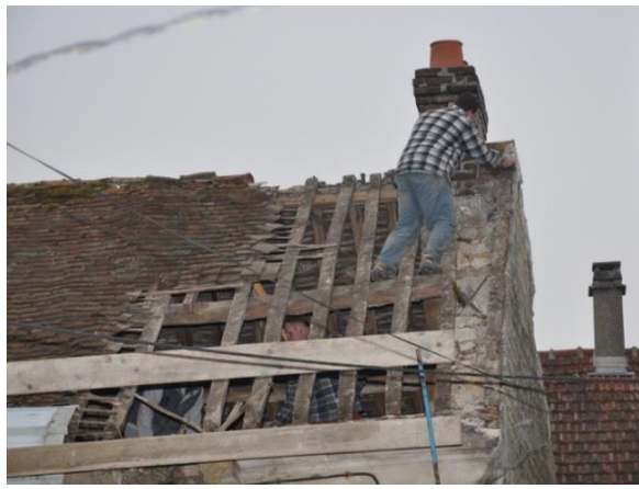
Figure 7 Déconstruction du toit et récupération des tuiles
