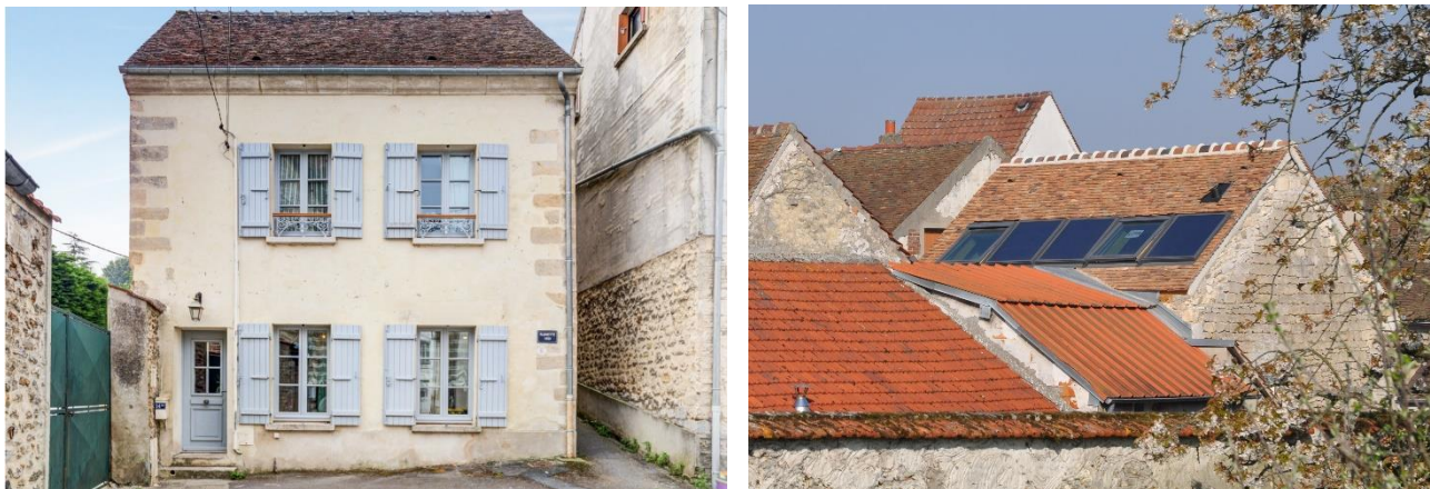
Figure 22 La maison « Ruinette » et son environnement proche au centre d'un bourg
