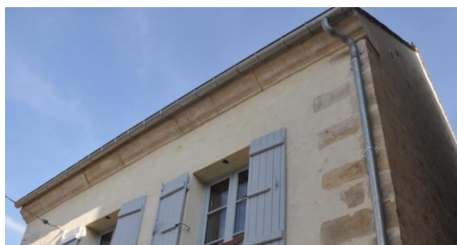
Figure 10 Enduit Chaux et corniche en plâtre
