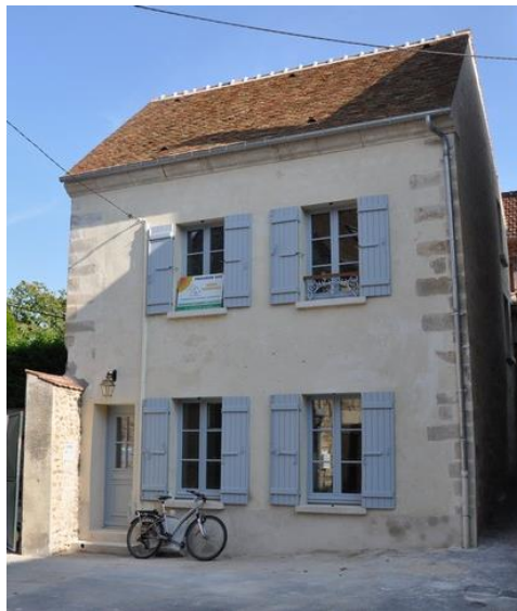
Figure 21 : Vue après travaux
