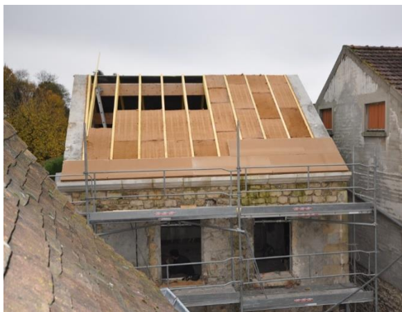
Figure 16 Pose des panneaux de fibres de bois à l'extérieur de la charpente
