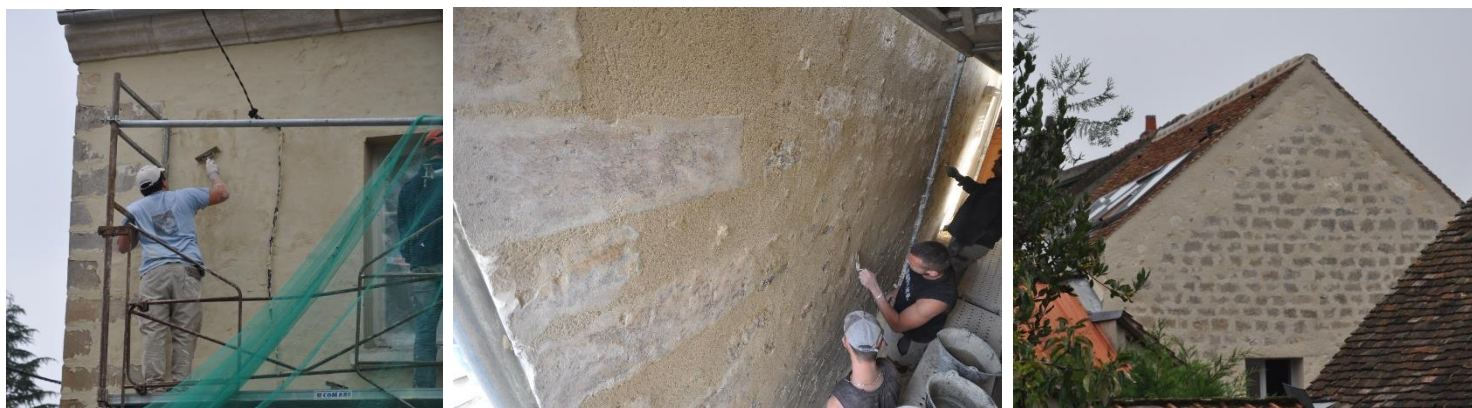
Figure 12 Pose d'un enduit plein sur la façade principale et d'un enduit à pierre de vue sur les façades orientées est et ouest
