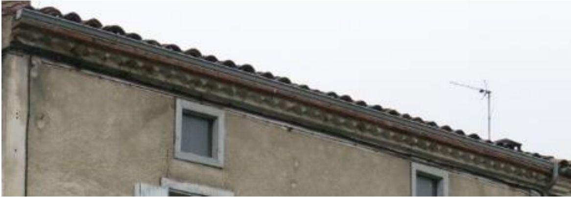
Figure 7 : Vue sur la génoise à simple rang sur la façade est
