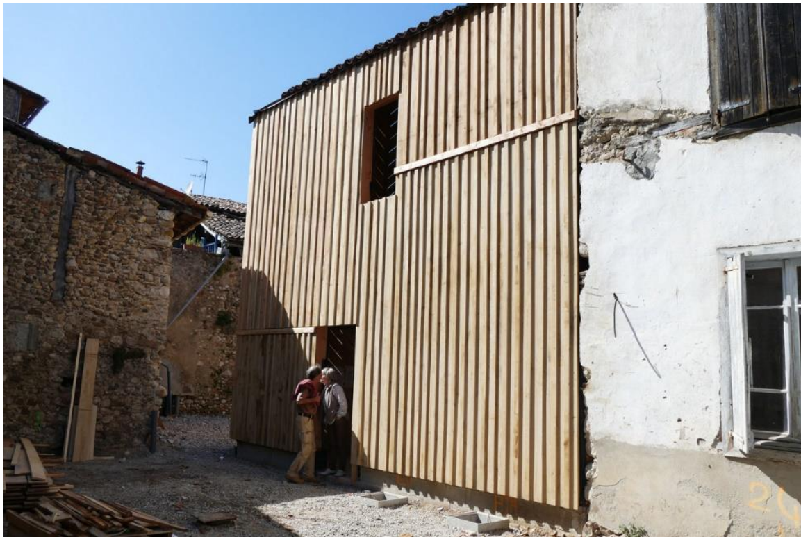
Figure 14 : Vue de l'extension avec bardage à lames verticales en acacia et mélèze brut, depuis la cour extérieure après démolition de la partie en briques
