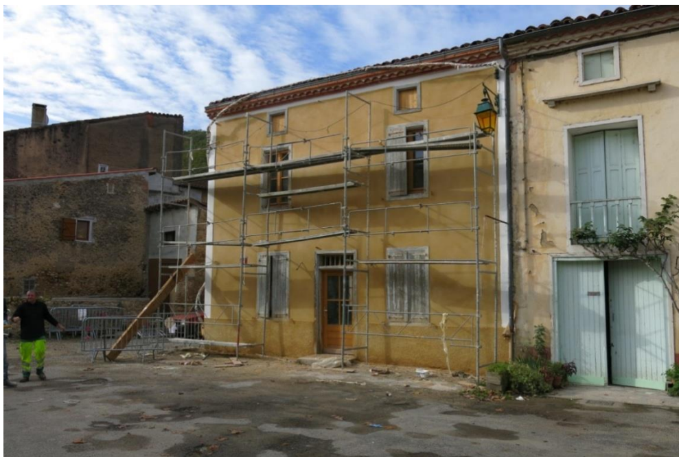
Figure 17 : Pose de l'enduit chaux sur la façade est (source : Barthélémy Dumons)
