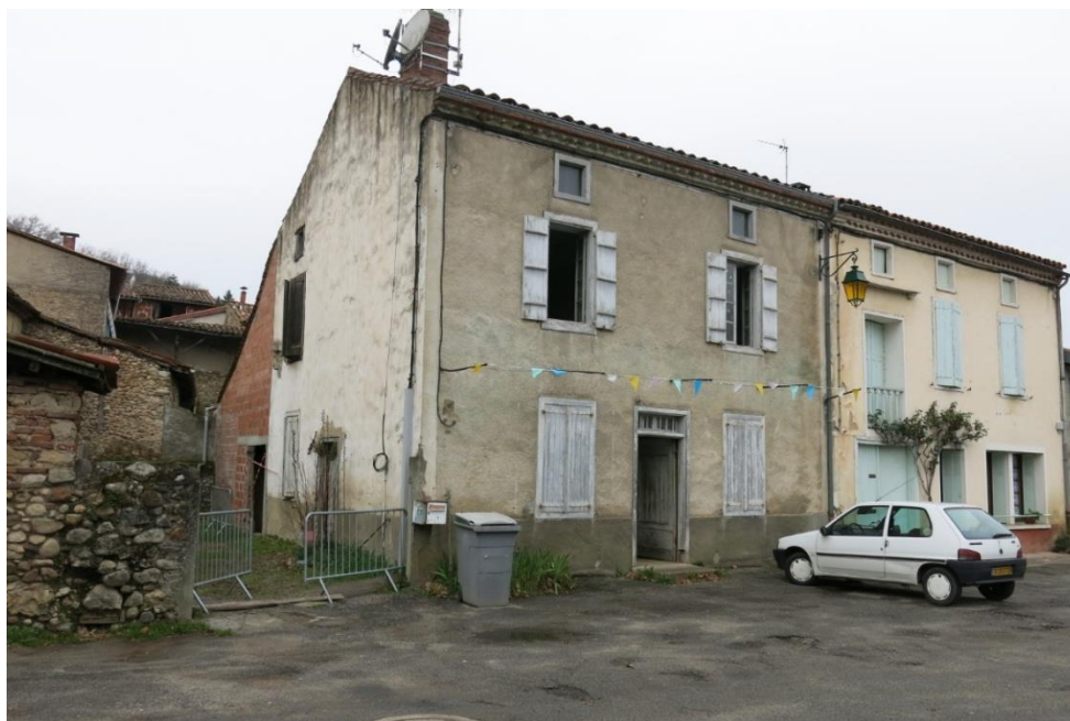
Figure 2 : Vue du bâtiment depuis la place de l'église avant les travaux (source : Barthélémy Dumons)
