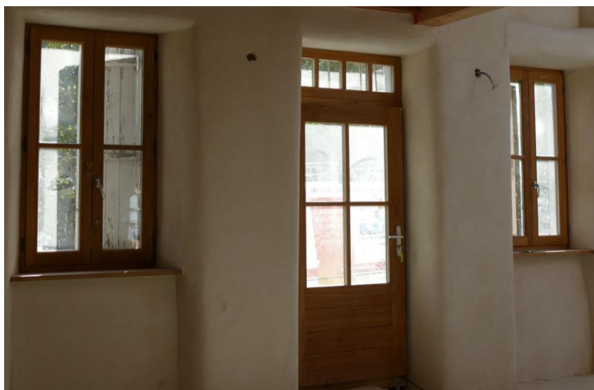
Figure 22 : Vue sur les menuiseries neuves en chêne
