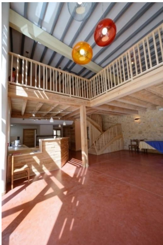
Figure 20 : Vue sur la mezzanine en douglas (source : Marc Mesplé)
