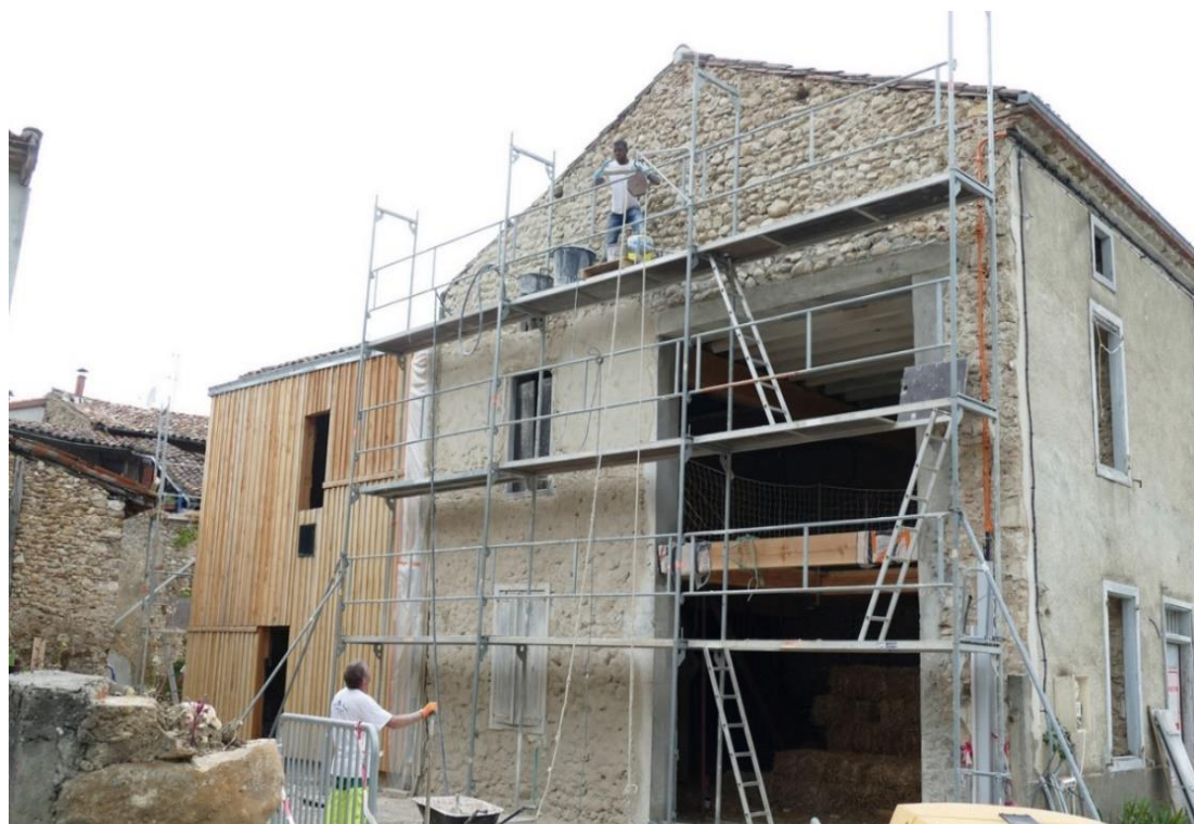
Figure 11 : Création de l'ouverture vitrée en façade sud, mise en œuvre de l'encadrement en béton armé et du linteau en bois au niveau intermédiaire
