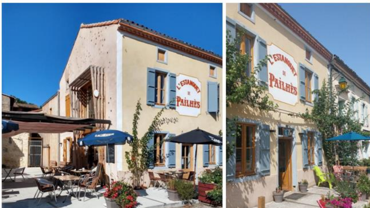
Figure 25 : Vue du bâtiment depuis la place de l'église après les travaux (source : L'Estanquet de Pailhès)
