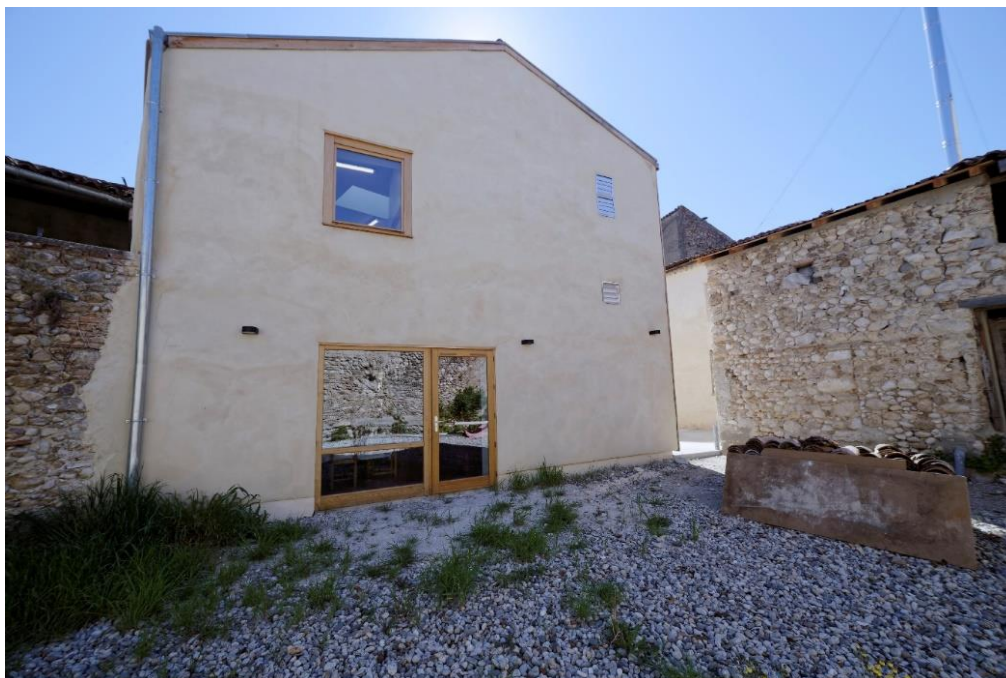
Figure 19 : Revêtement à la chaux du mur ouest isolé à la paille (source : Barthélémy Dumons)
