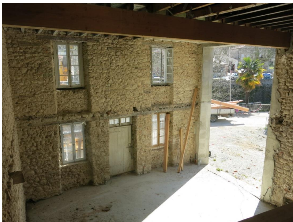
Figure 3 : Maçonnerie de pierres apparentes une fois l'enduit retiré (source : Barthélémy Dumons)
