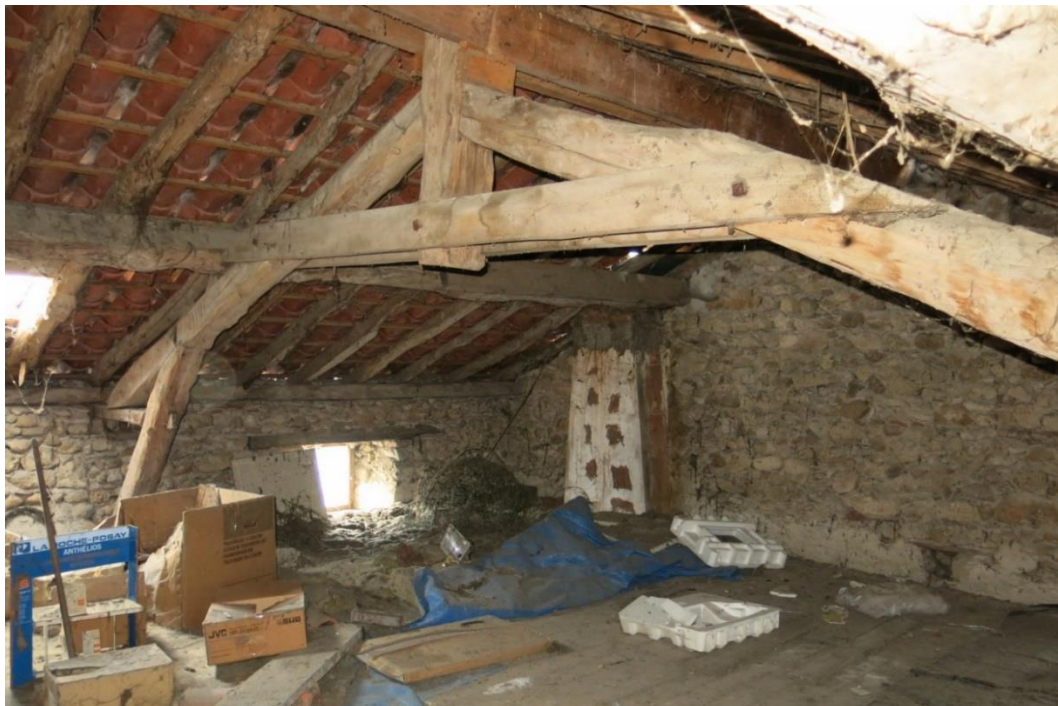
Figure 4 : Etat des combles avant travaux (source : Barthélémy Dumons)
