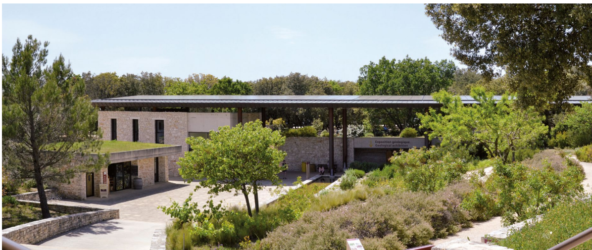
Panneaux photovoltaïques sur la maison d'accueil du Grand Site de France, Aven d'Ornac. © Françoise Prud'homme
