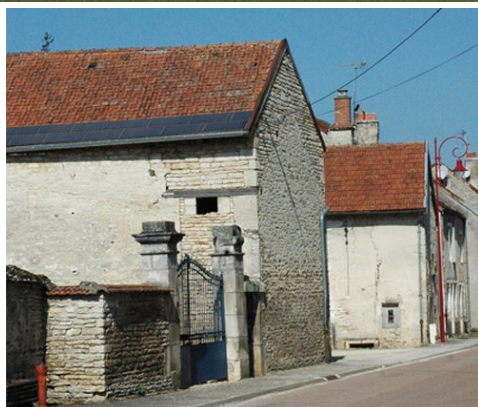
Panneaux sur la rive d'égoût, Haute-Marne. © Agathe Lukasek (Drac Grand-Est)
