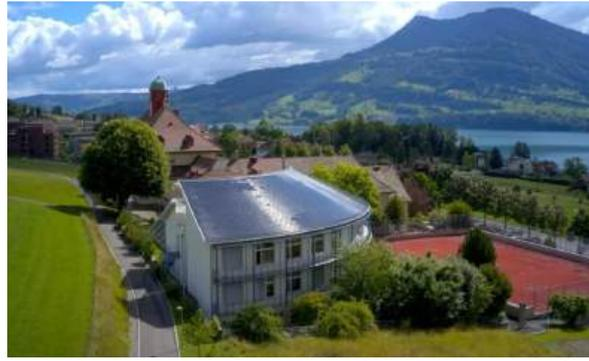
Figure 20 : Exemples d'installations solaires intégrées de modules colorés de format adapté à la trame de la toiture original (source : freesuns).
