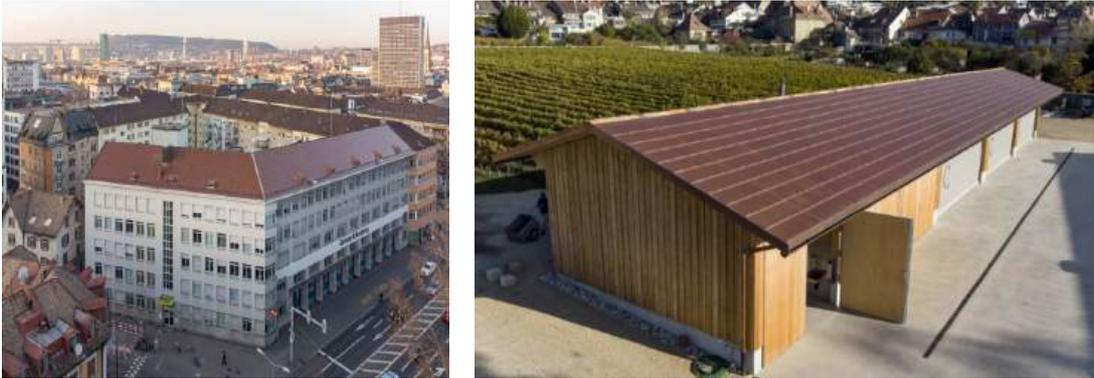
Figure 19 : Exemple d'installation solaire intégrée avec modules colorés de format adapté à la trame de la toiture original (source : Solaxess, LMNT).
