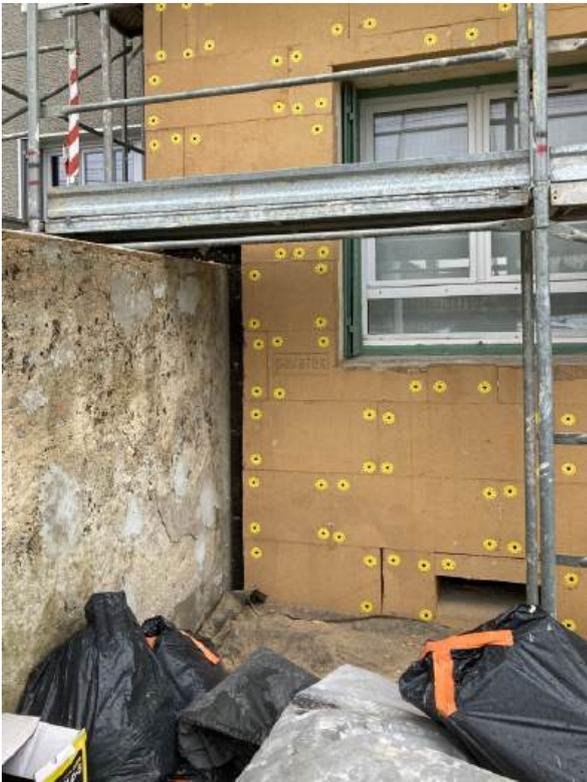
Sur ce chantier situé 14 rue Martin à Lyon 3, les tests à l'arrachement réalisés par le fabricant se sont révélés concluants. Aucune mise en œuvre spécifique n'a donc été requise pour la pose des panneaux isolants en fibres de bois collés-chevillés sur le mur en béton de mâchefer, © Aerial architectes
