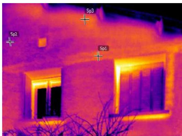
Thermographie réalisée sur une maison individuelle type « Castor » de 1957 sise 7 allée des Troènes à Lyon 5 en février 2018. Les éléments les plus déperditifs repérés sont les chaînages et les liaisons entre le bâti et les menuiseries. © Cerema pour le CAUE Rhône Métropole
