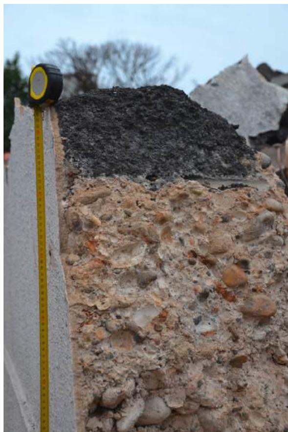
Maçonnerie en béton de gravier (ht. 120 cm) sur un bâtiment en mâchefer en cours de démolition à Lyon 4, 2018, © J. Sordoillet, CAUE Rhône Métropole
