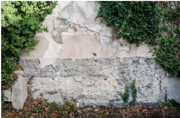
Plusieurs strates de maçonnerie représentatives des différents bétons élaborés par François Coignet. Ces essais sont encore visibles sur le mur de soutènement de la maison construite en 1853 à Saint-Denis (93), 2017, © F. Gaboriau
