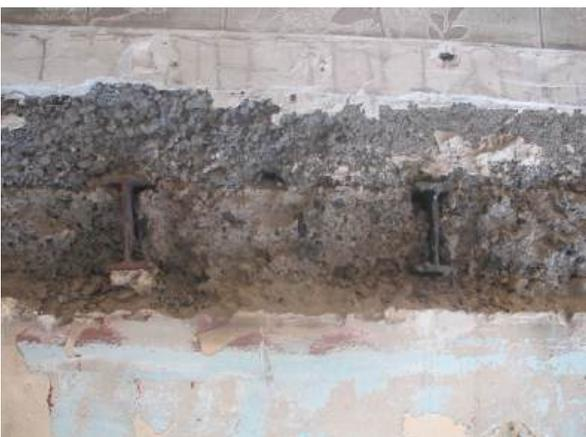
Têtes de poutrelles acier enchâssées dans le mur en mâchefer, photographie prise à l'occasion de l'ouverture d'une trémie dans une dalle d'étage lors du chantier de rénovation d'une maison individuelle sise 21, av. des acacias 69003 Lyon, 2019, © G. Cluzel, CAUE Rhône Métropole
