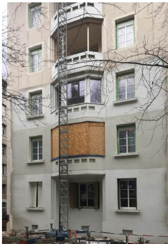
Projection d'un enduit thermo-isolant (Fixit222 ®) sur une maçonnerie en pisé de mâchefer et phases de finitions, chantier de réhabilitation énergétique de la Cité HBM des États-Unis (Tony Garnier architecte) en 2021, 74 boulevard des États-Unis, Lyon 8 - Entreprise : Reppelin - Maître d'ouvrage : GLH - Maître d'œuvre : C&P architectes - © G. Cluzel, CAUE Rhône Métropole
