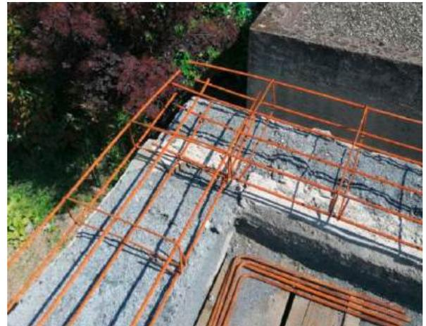
Mise en place des fers pour ceinture béton support surélévation © A. Gély
