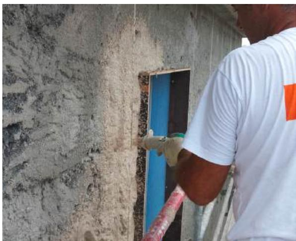
Projection d'un enduit thermo-isolant chaux-silice, Cité des États-Unis, 72, boulevard des États-Unis, Lyon 8, T. Garnier architecte (1935) – Chantier de réhabilitation énergétique (2021), C&P architectes, © CAUE Rhône Métropole – G. Cluzel
