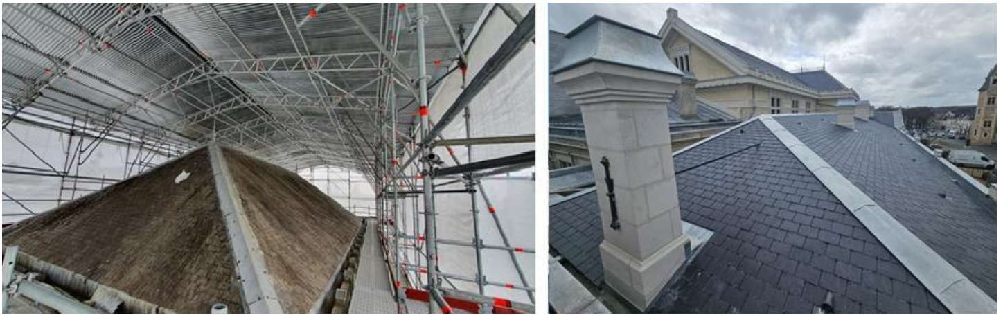
Figure 17 : Toiture après travaux
