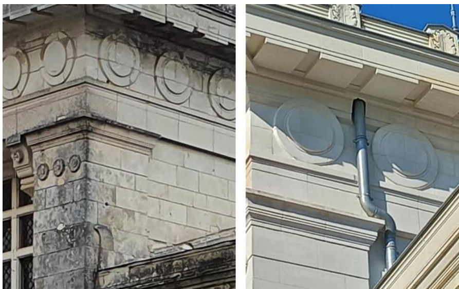
Figure 12 : Descente des eaux pluviales avant et après travaux
