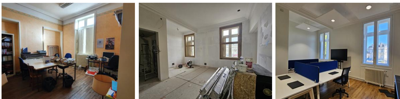
Figure 16 : Isolation thermique par l'intérieur de l'aile Est
