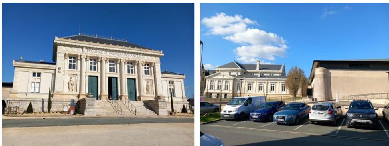
Figure 5 : À gauche : façade – À droite : liaison entre le tribunal et la prison
