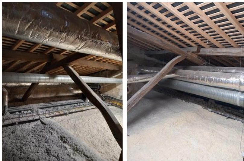
Figure 18 : Isolation des combles
