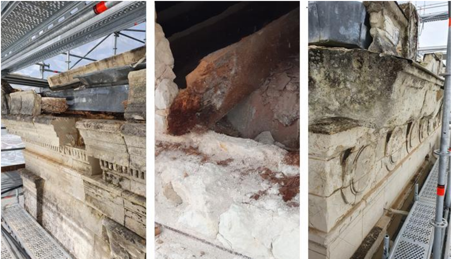
Figure 14 : Pierres de tuffeau avant travaux
