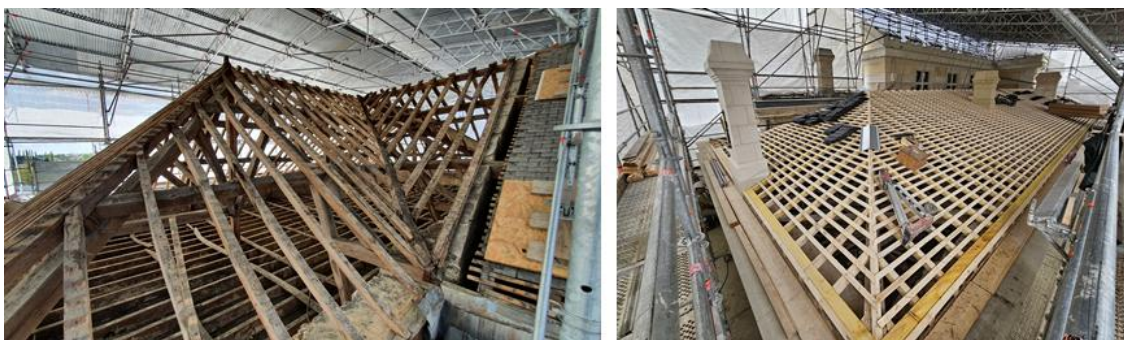
Figure 15 : Charpente avant et après travaux
