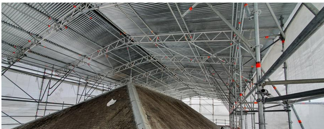
Figure 11 : Dispositif de chantier de type "parapluie"
