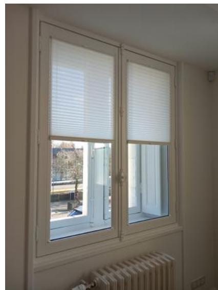
Figure 20 : Double fenêtre intérieure
