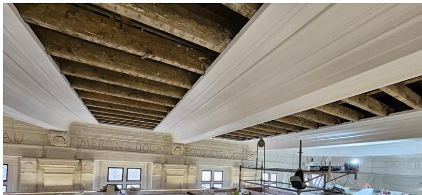
Figure 19 : Travaux sur le plancher haut de la salle des Pas Perdus
