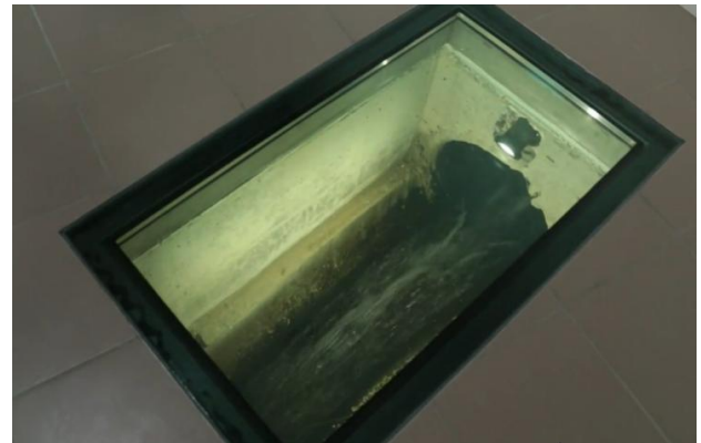
Figure 38 : Dalles en verre permettant une vue sur le bief Extrait du document « Le centre de ressources sur l'habitat durable » du Pilat Source : Noémie Richard architecte - Photo : Atelier de la Jonque
