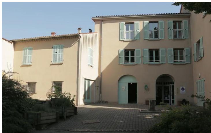
Figure 16 : La maison avant travaux
