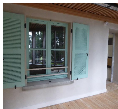
Figure 43 : Une fenêtre de la maison de la gardienne a été conservée à titre mémoriel Source : Cerema
