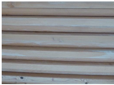
Figure 37 : Plancher autoportant de l'étage – Les lames décalées piègent les sons dans la salle de réunion au rez-de-chaussée Source : Cerema, Atelier de la Jonque
