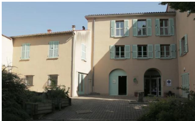
Figure 5 : Façade Sud avant travaux
