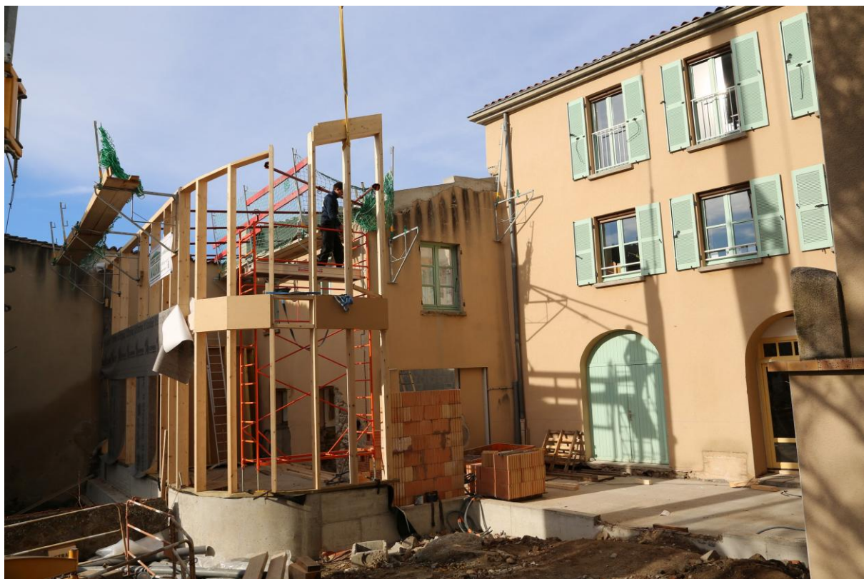
Figure 14 : Travaux pour l'extension sur la façade Sud de la maison du gardien
