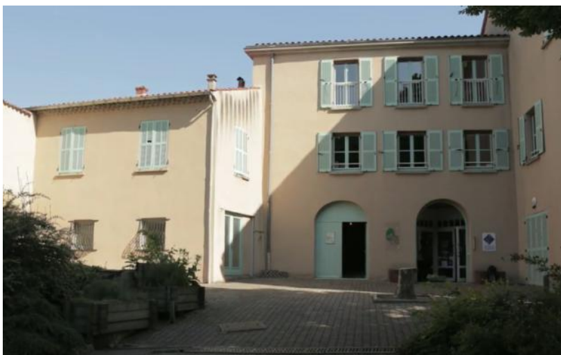
Figure 9 : Façade Sud avant travaux
