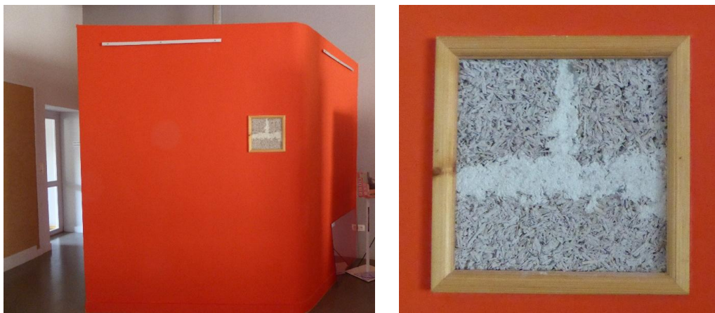
Figure 45 : Cloison des toilettes en blocs chaux-chanvre Source : Cerema
