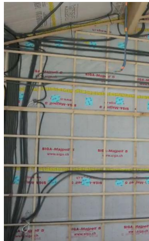
Figure 41 : Espace technique à l'avant du pare-vapeur
