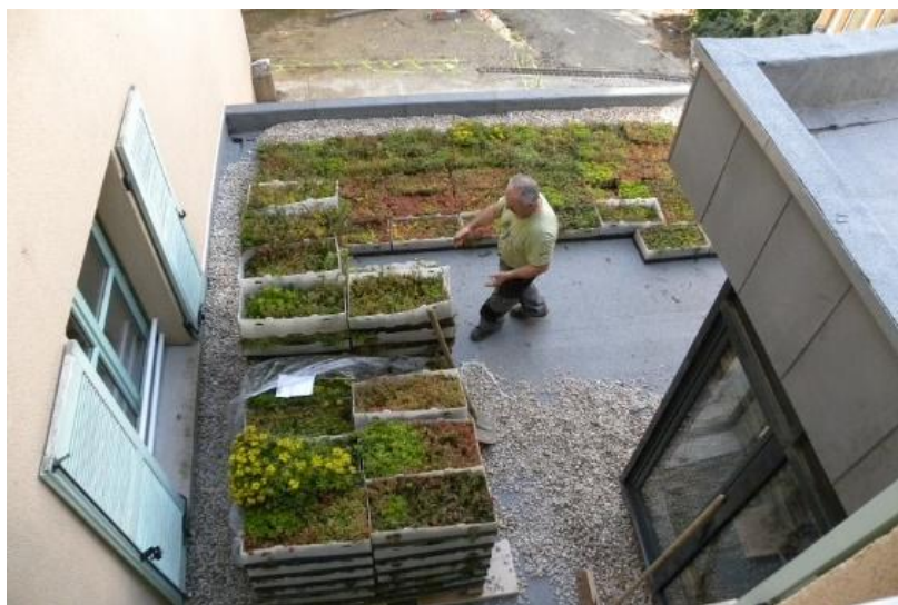
Figure 26 : Installation de la toiture végétalisée
