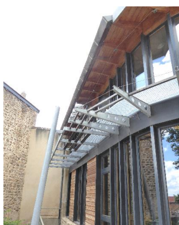
Figure 44 : Casquette protégeant l'étage et support de grimpante pour le rez-de-chaussée Source : Cerema
