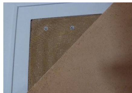
Figure 48 : Mur de refend chauffant Source : Cerema
