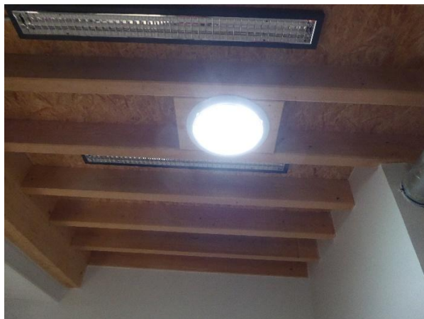
Figure 29 : Deux puits suffisent à l'éclairage de la salle de réunion du rez-de-chaussée Source : Cerema
