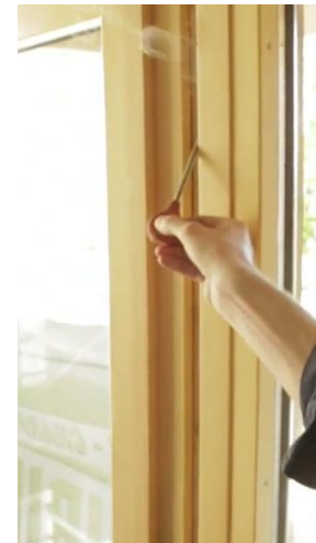
Figure 40 : Contrôle de l'étanchéité des menuiseries
