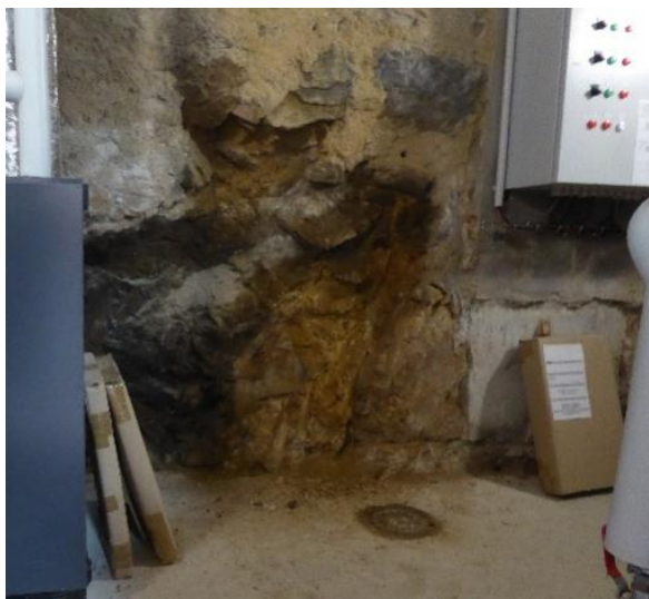
Figure 8 : Mur semi-enterré laissé apparent dans le local technique
