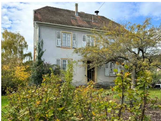
Figure 4 : Vue du presbytère avant travaux (source Fondation du Patrimoine)
