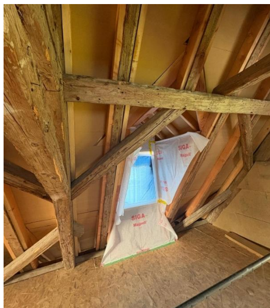
Figure 27 : Photo des travaux d'isolation en sarking et dédoublement des chevrons (source Mayker Architectes)
