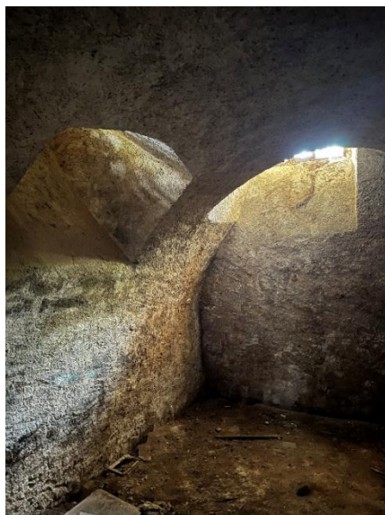
Figure 7 : Cave voûtée dans son état existant (source Mayker Architectes)
