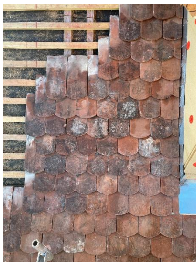
Figure 31 : Réemploi des tuiles in-situ (source Mayker Architectes)
