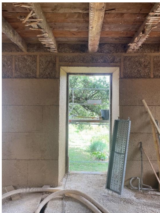
Figure 24 : Mise en œuvre de la correction thermique sur chantier
