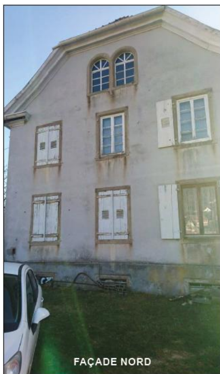
Figure 18 : Vue de la façade nord (source L. KWIATKOWSKI)
