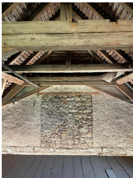
Figure 11 : Photo des combles et de la charpente dans leur  tat existant (source Mayker Architectes)
