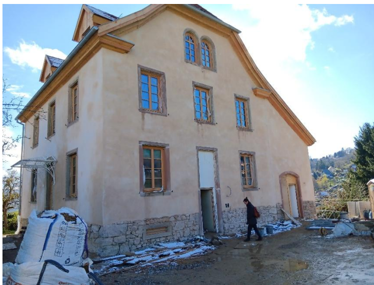
Figure 25 : Aspect extérieur après finition à l'enduit à la chaux
