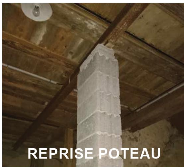
Figure 8 : Reprise structurelle d'un poteau du sous-sol (source L.KWIATKOWSKI)
