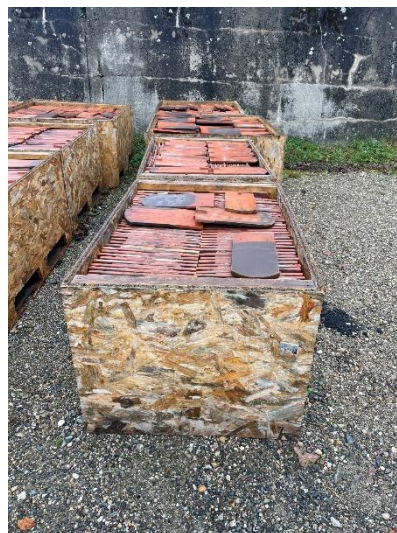
Figure 30 : Réemploi des tuiles in-situ (source Mayker Architectes)
