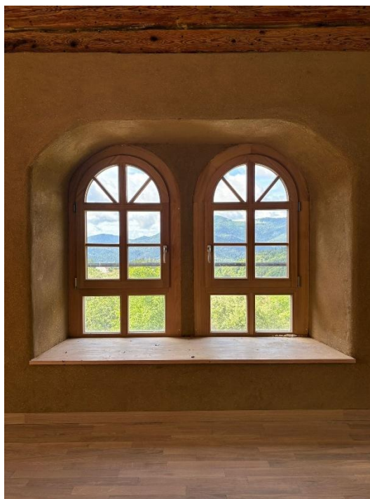
Figure 37 : Les doubles fenêtres cintrées neuves vues depuis l'intérieur
